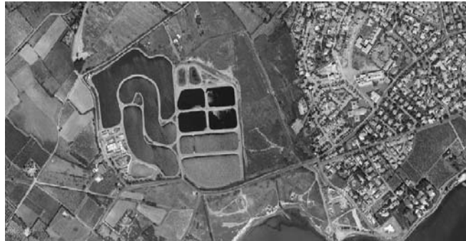
Figure N°08 : Vue aérienne des immenses lagunes de la STEP de Mèze
