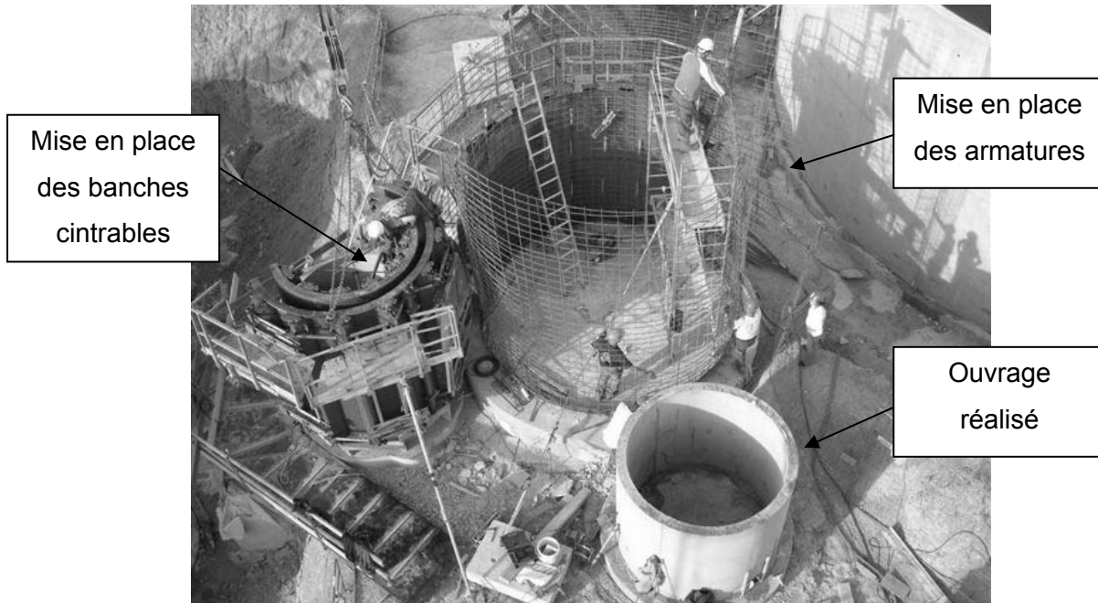
Figure N°34 : Ouvrages de petits diamètres à différents stade de réalisation
