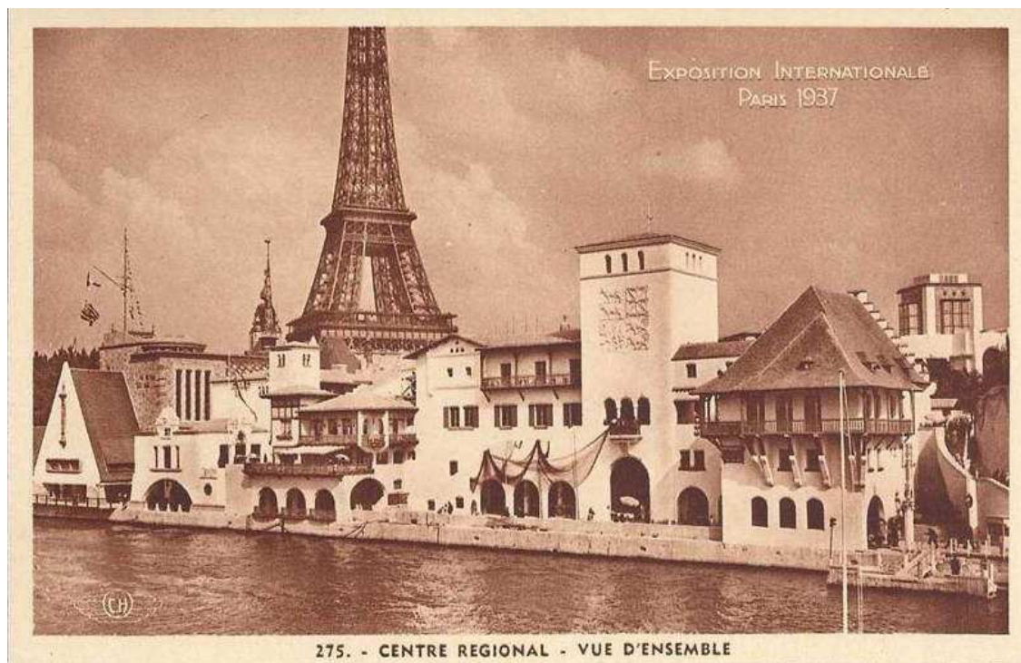
Figure 25 - Centre régional - vue d'ensemble, H Chipault
