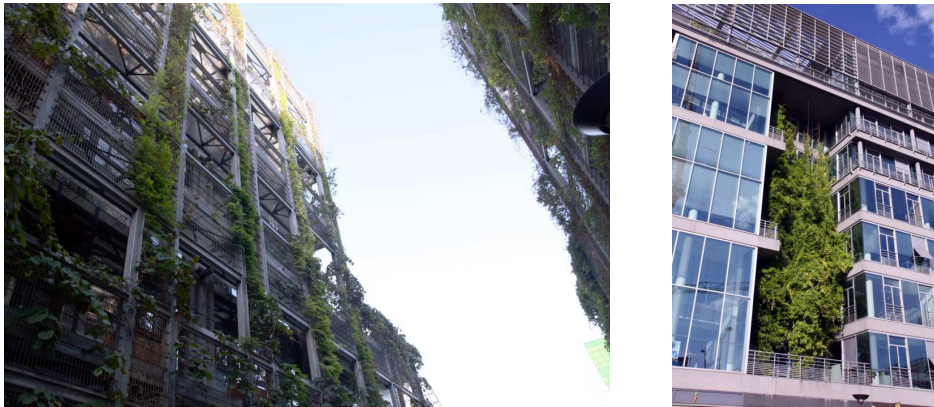
FIG. 2.3: Protection solaire végétale
