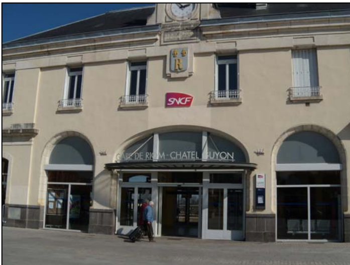
Figure n°5 : Parvis de la gare SNCF Riom-Châtel-Guyon
