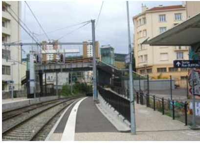
Photo 4 : Accès à la nouvelle passerelle, le lien direct vers la ville
