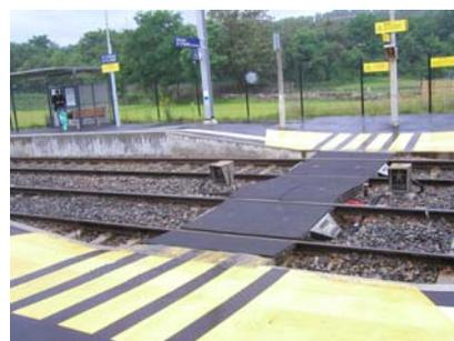
**Photo 3** : Traversée planchéiée piétonne et pictogrammes
