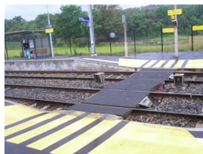
Photo 3 : Traversée planchéiée piétonne et pictogrammes
