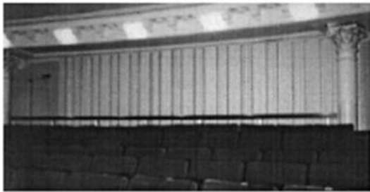
Fig. 1 – Diffuseurs de Schroeder, mur arrière du Carnegie hall (Cox & D'Antonio).
