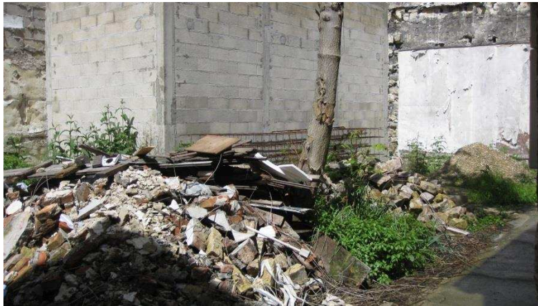
Figure 20. Photo d'un immeuble détruit en fond de parcelle au bout de l'impasse Savart. 109
