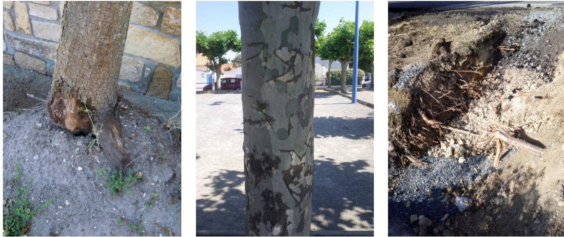
Figure 6 : Blessures courantes portées aux arbres (Paillat, 2013) De gauche à droite : écorce arrachée par une pelle mécanique ; incisions au couteau sur écorce de platane ; racines sectionnées lors de l'ouverture d'une tranchée
