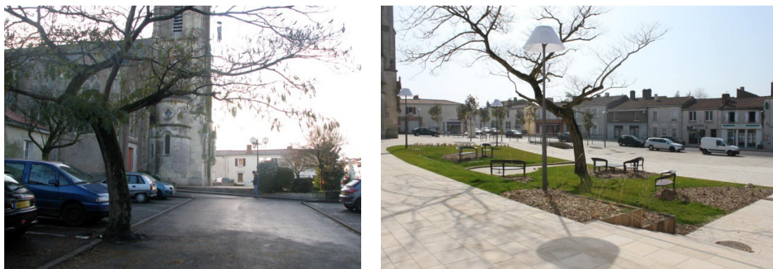
Figure 18 : Aménagement favorisant l'infiltration d'eau autour d'un Albizzia, Place de l'église à La Chevrolière (Atelier 360°, 2009, 2012). A gauche : Albizzia avant aménagement ; à droite après aménagement.
