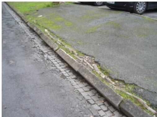
**Figure 8 : Accroissement d'une racine de platane à Angers le long d'une bordure béton, provoquant sa déformation. (Gourves A. 2013)**
