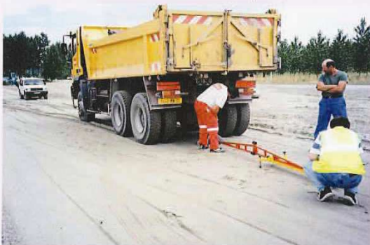
Plaque de diamètre 600 mm avec poutre Benkelman.
