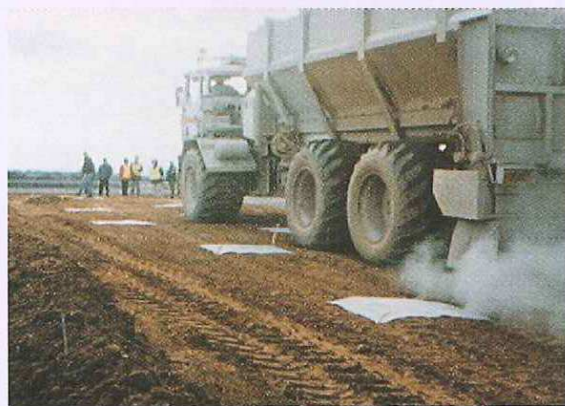
Positionnement aléatoire des bâches sur chantier.
