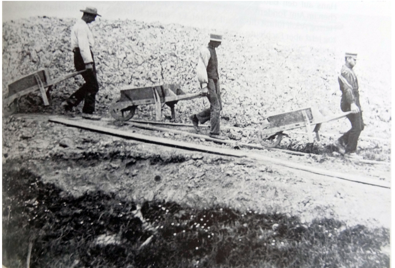
La construction des digues. Nordfriisk Institut
