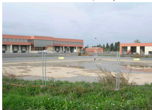
Photo 6 Écopôle (Source : CEREMA, ex-CETE méditerranée, 2012)
