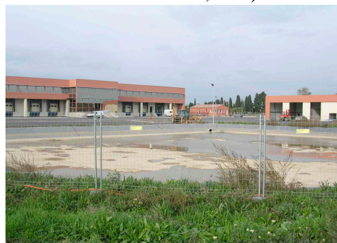
Photo 6 Écopôle (Source : CEREMA, ex-CETE méditerranée, 2012)
