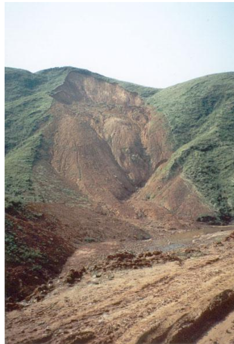
Figure 26 : Glissement de terrain [30]
