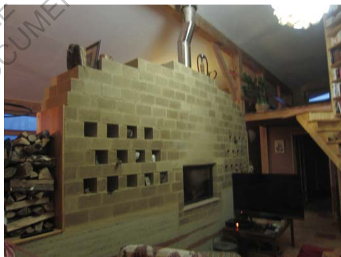
Figure 29: Mur capteur en pise
