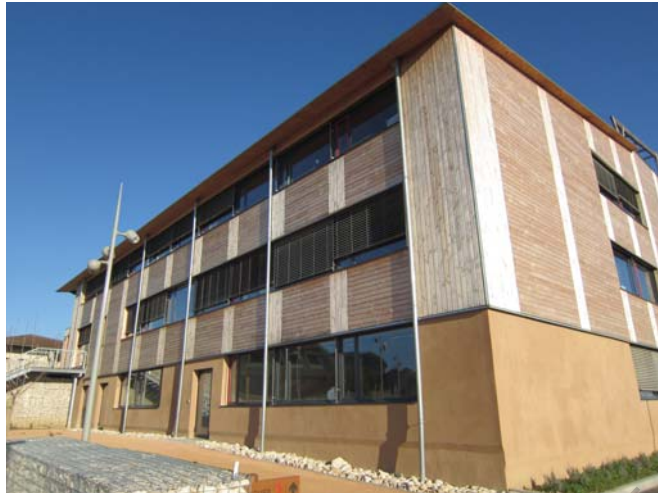
Figure 1: le bâtiment dans son environnement (vue sud)
