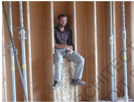
Figure 6: Remplissage de caisson avec de la paille
