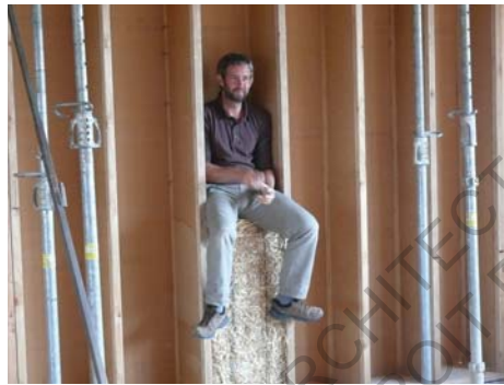
Figure 6: Remplissage de caisson avec de la paille
