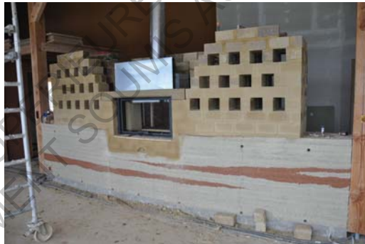
Figure 23: Mur capteur en pise
