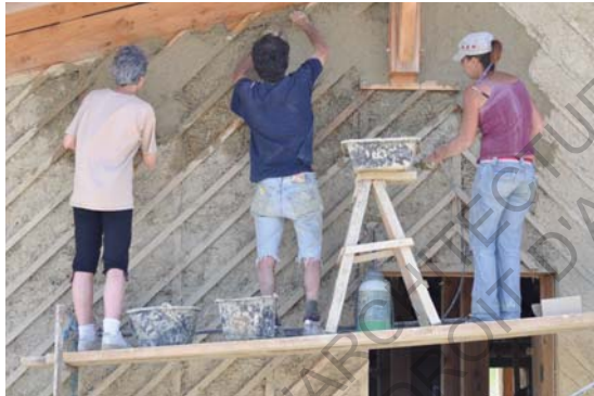
Figure 22: Enduit cote extérieur
