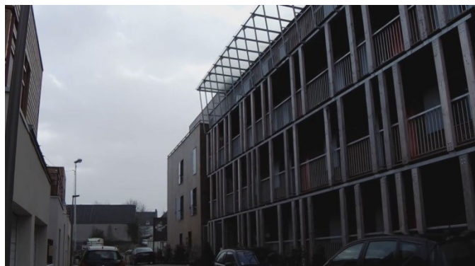
Figure 30 : Prise de vue n°6 depuis la rue Georges Clémenceau, Montlouis-sur-Loire (37). Source : Frédéric Nobileau, 2014.
