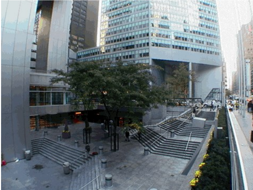
Figure 44 : La nouvelle station de métro spécialement réalisée pour la construction de la tour 599 Lexington Avenue à Manhattan (USA), imaginée par Edward Larrabee Barnes. Source : Éric Firley, Julie Grimbal, La tour et la ville manuel de la grande hauteur , 2011.
