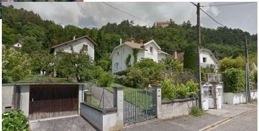
Figure 6 : Prise de vue depuis l'avenue du Verger, Corenc (38). Source : Google Maps.
