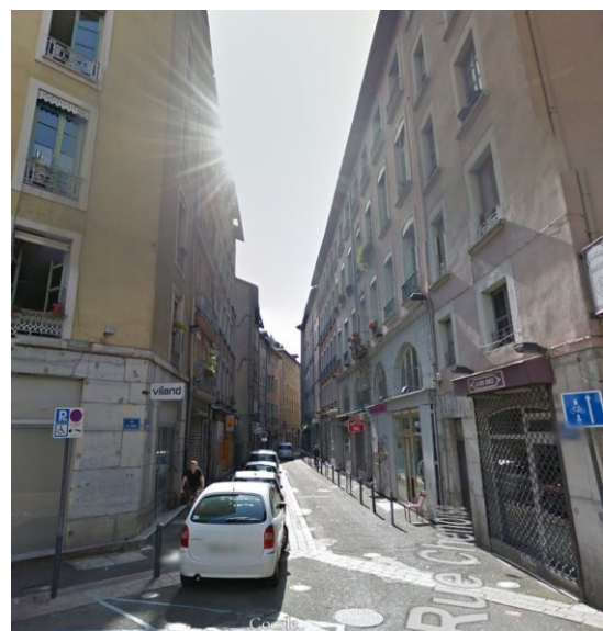
Figure 18 : Prise de vue depuis la rue Chenoise, Grenoble (38). Source : Google Maps.
