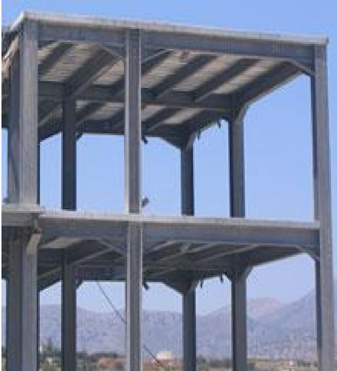
Fig. 1: Vue général d'un bâtiment métallique
