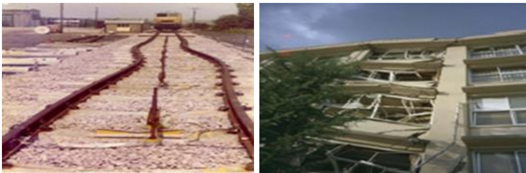
Fig. 18 : Flambement des rails et Collision des étages
