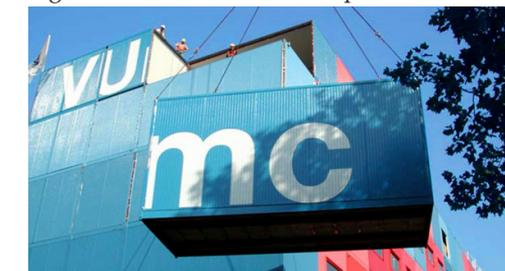
Fig.39: installation de la structure en conteneurs préfabriqués.
