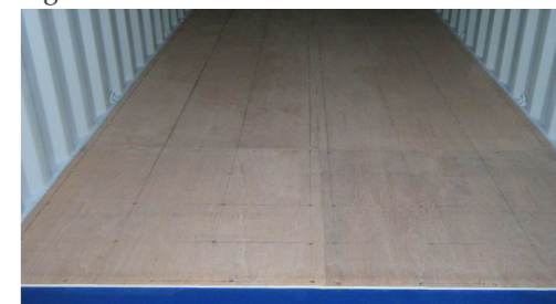
Fig.53: plancher de bois d'un conteneur.
