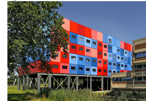
Fig.38: Extérieur du bâtiment provisoire.
