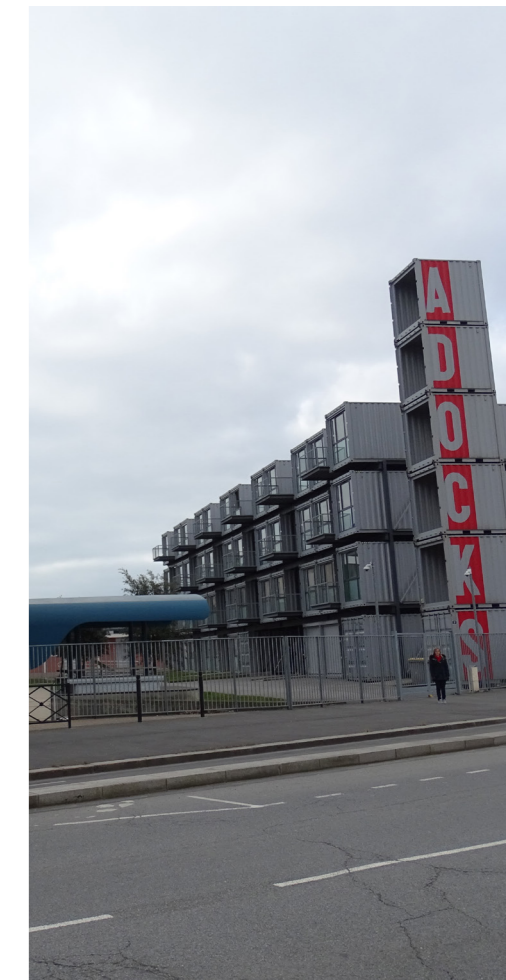
Fig.92: cité A'Docks sur les docks du Havre.
