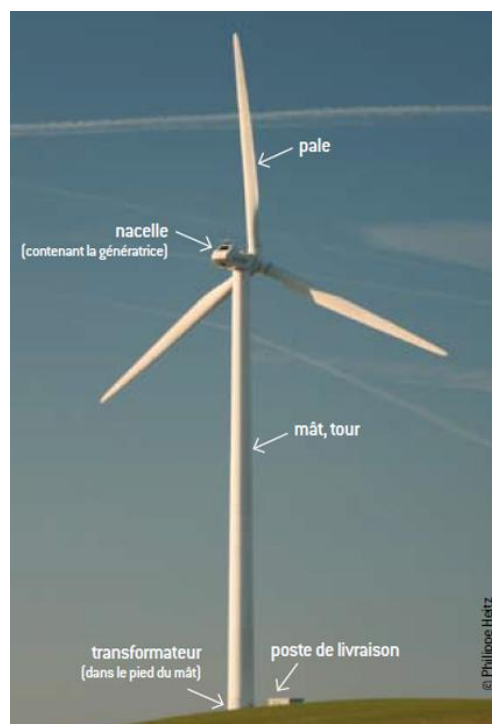
Figure 4 : Principaux composants d'une éolienne (DDT, 2010)
