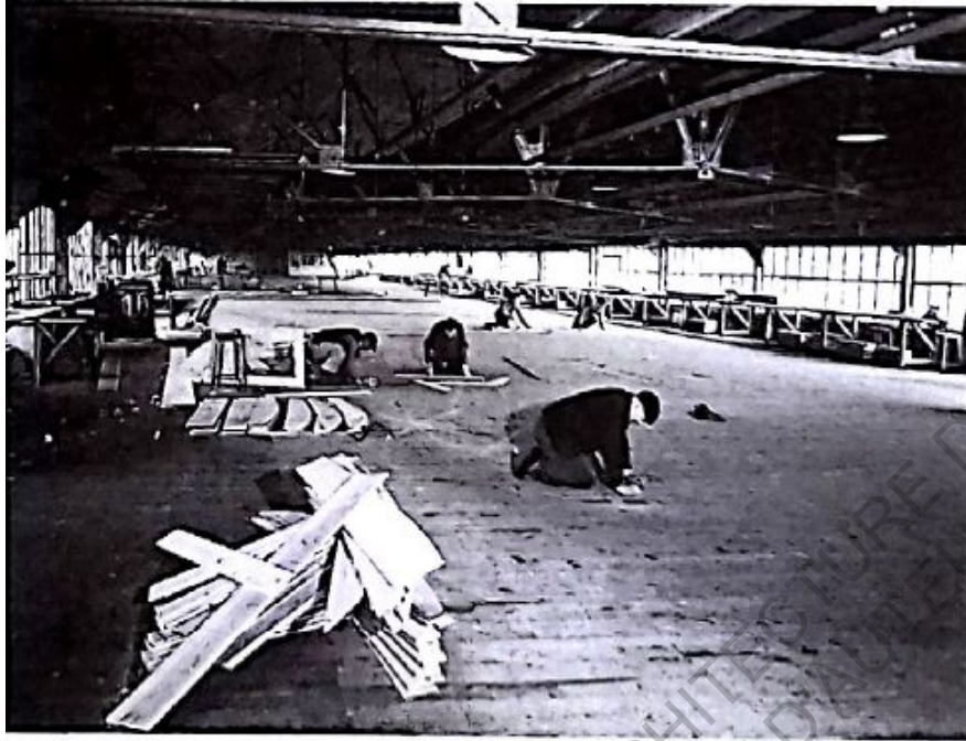
Figure 4.31 A l'intérieur de la salle à tracer des anciens chantiers Dubigeon
