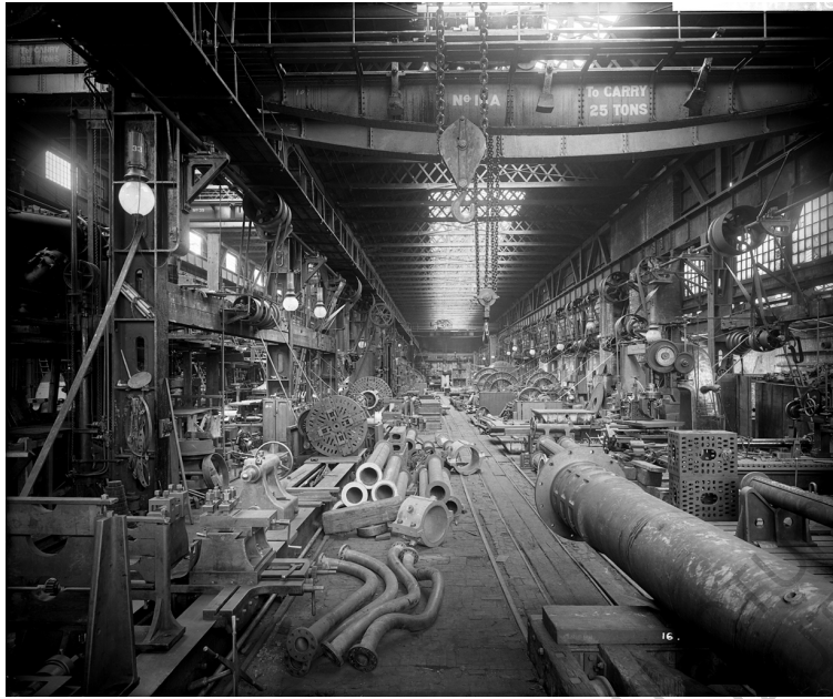
Figure 4.29 A l'intérieur de l'atelier des machines-outils des anciens chantiers Dubigeon
