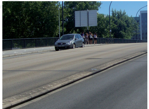
Figure 6 : sur le busway de Nantes, un site propre séparé physiquement de la chaussée (Pierre DUHAMEL)
