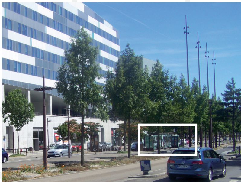
Figure 14 : une station du busway de Nantes et son accompagnement végétal
