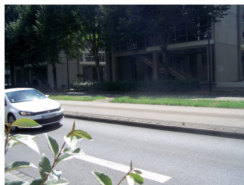
Figure 10 : Le site propre surélevé du Busway de Nantes (Pierre DUHAMEL)
