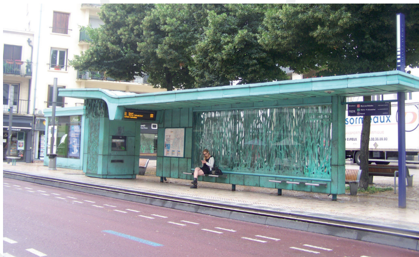
Figure 16 : La Station ouvragée «Cathédrale», à Rouen.
