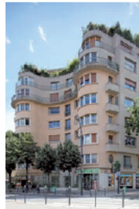
5 7 rond-point du Pont-Mirabeau 2 rue de la Convention, 15 e IMMEUBLE DE LOGEMENTS Joseph Bassompierre, Paul de Rutté, Paul Sirvin, architectes 1932
