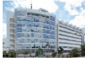
4 2 rue des Cévennes 85-89 quai André-Citroën IMMEUBLE DE BUREAUX Richard Meier, architecte 1991
