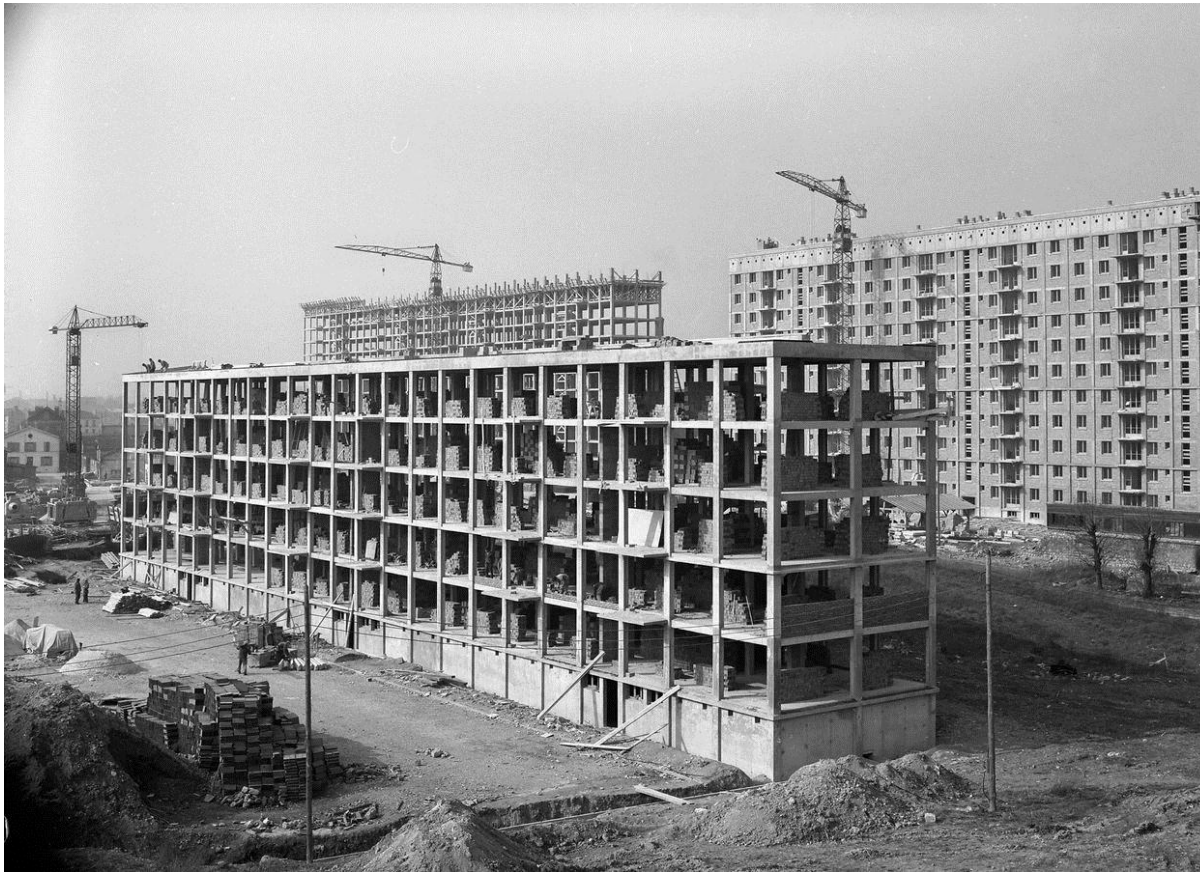
Fig n°1 : la construction des GE, ici à Arcueil et Gentilly en 1958
