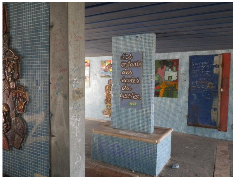
Fig n° 59: Le porche du bâtiment M, un espace occupé par les jeunes
