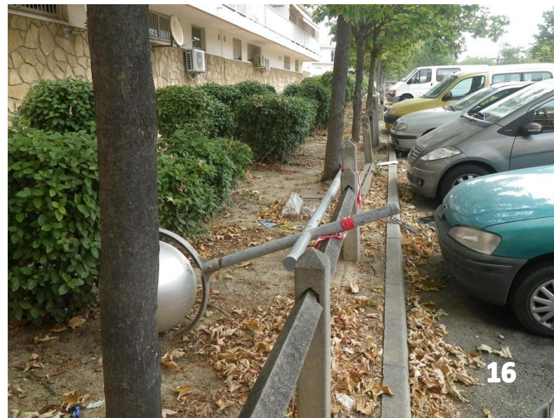
Fig n°52 : Un candélabre dégradé symbole des problèmes de gestion du site
