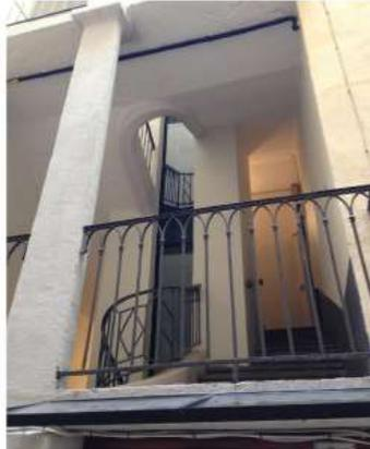
*Insertion d'un ascenseur dans le jour central d'un escalier suspendu à limon. Mutilation des marches et des garde-corps.*
