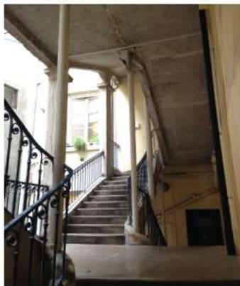
*Escalier remarquable fragilisé par l'usure du temps. Ajout moderne de soutènement (pilier).*
