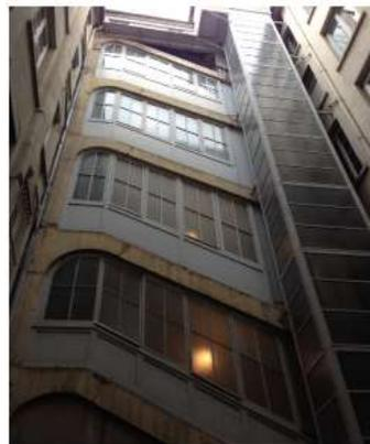
*Fermeture des baies de l'escalier. Installation d'une colonne d'ascenseur opaque sur cour.*
