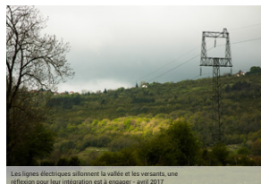
Les lignes électriques affirment la vallée et les versants, une réflexion pour leur intégration est à engager - avril 2017
