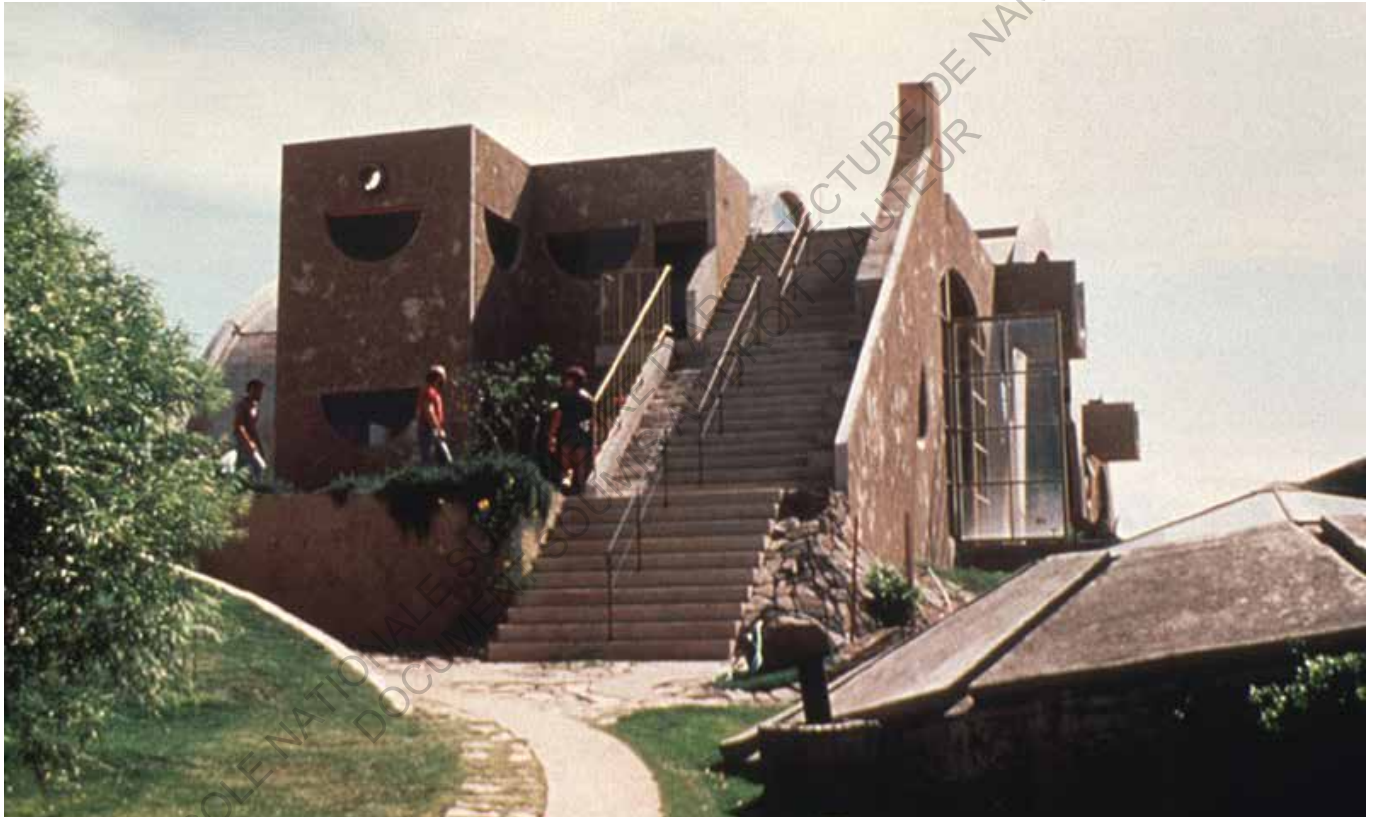
L'approche West Housing. Une grande baie donne sur le sud et l'escalier nous amène en haut de la voûte [69]
