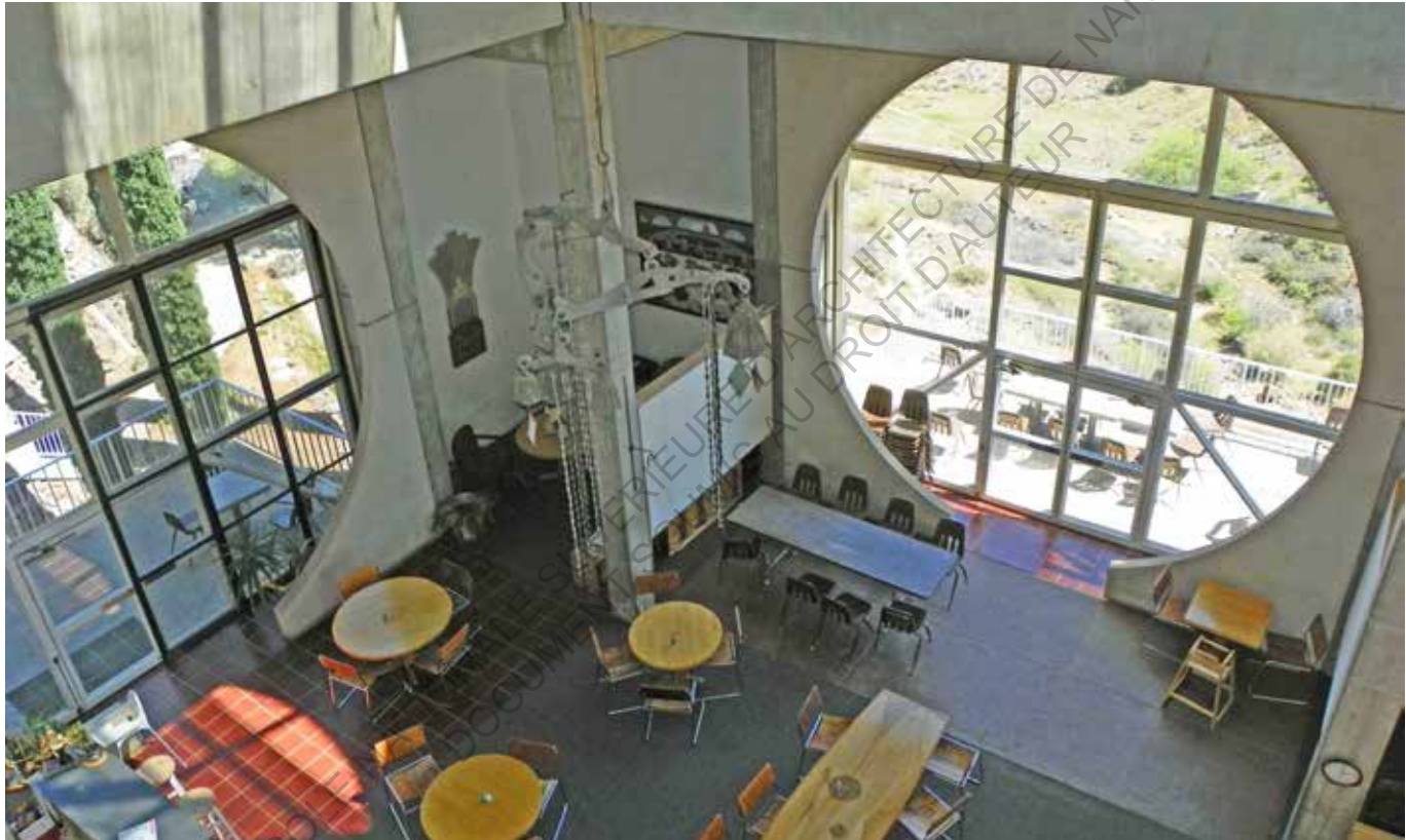
Intérieur de Crafts III, Les grandes baies permettent de chauffer et d'éclairer l'intérieur du bâtiment [61]
