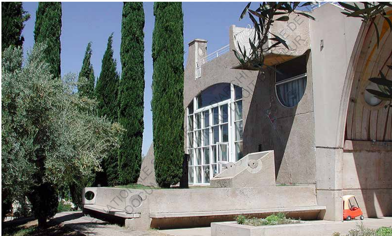
Vue côté sud du West Housing qui est connecté avec le Vaults [70]
