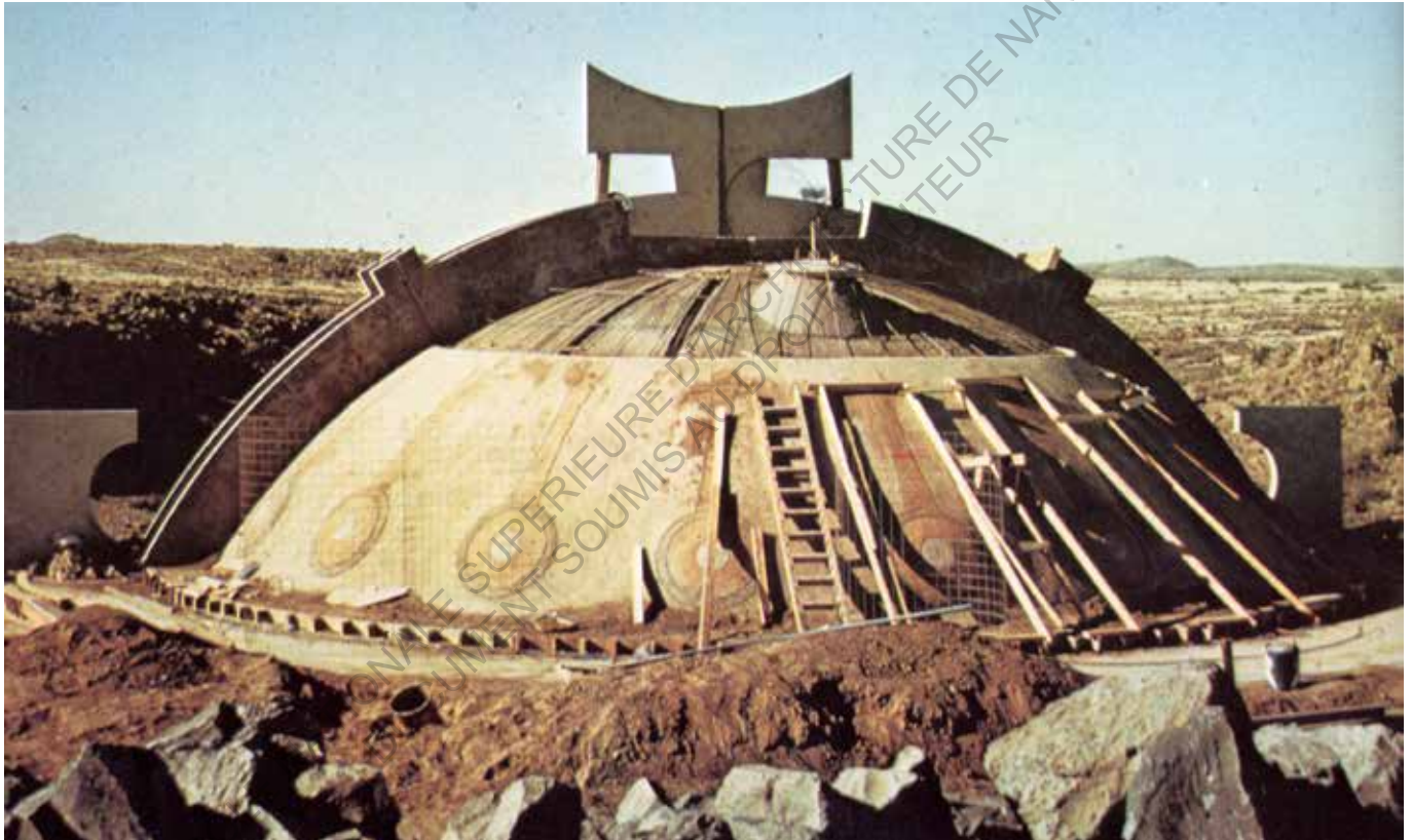
La construction du Ceramics Apse à la façon de "Earth Casting" [65]
