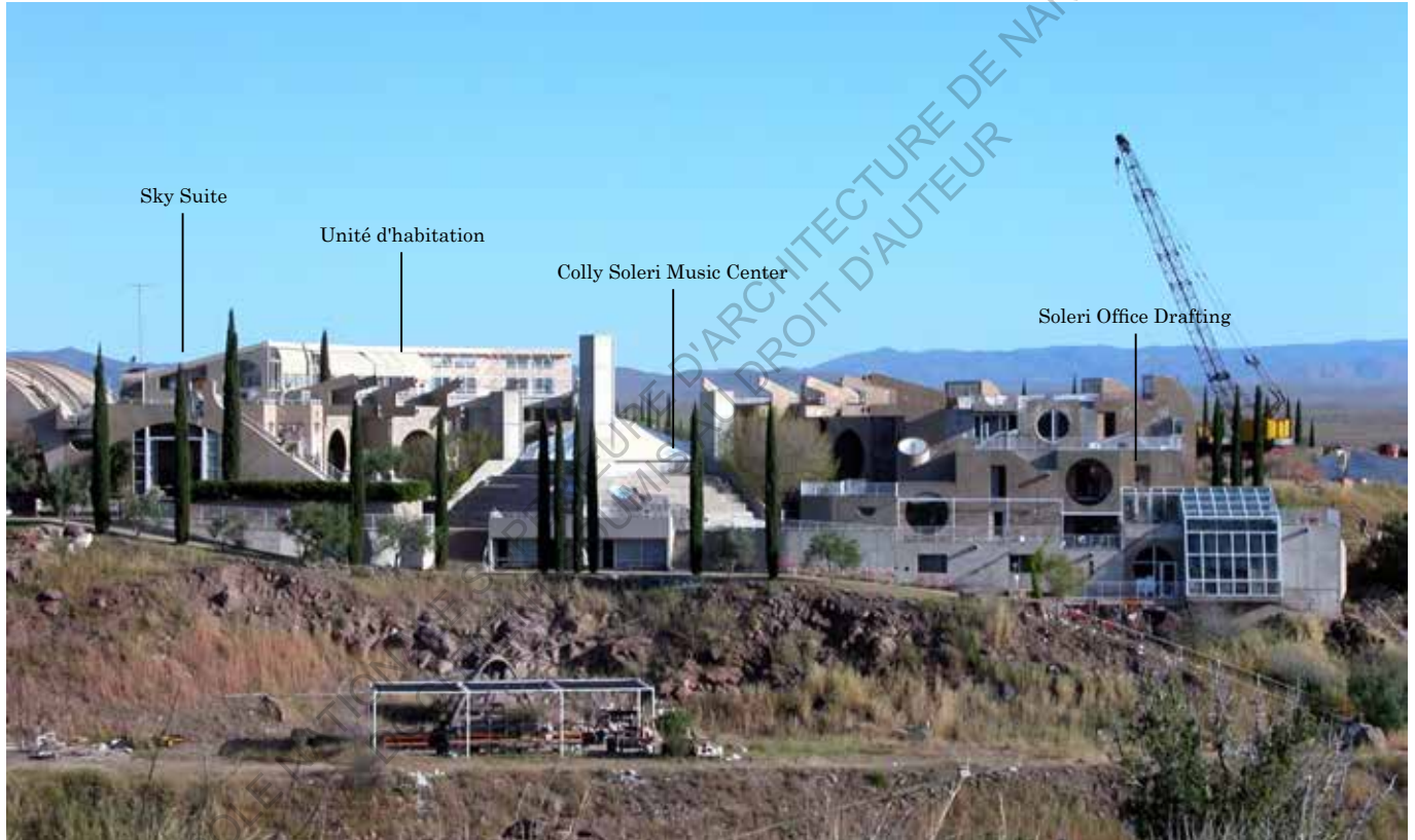
Vue globale du East Crescent, Colly Soleri Music Center au milieu et des unités d'habitation autour [74]
