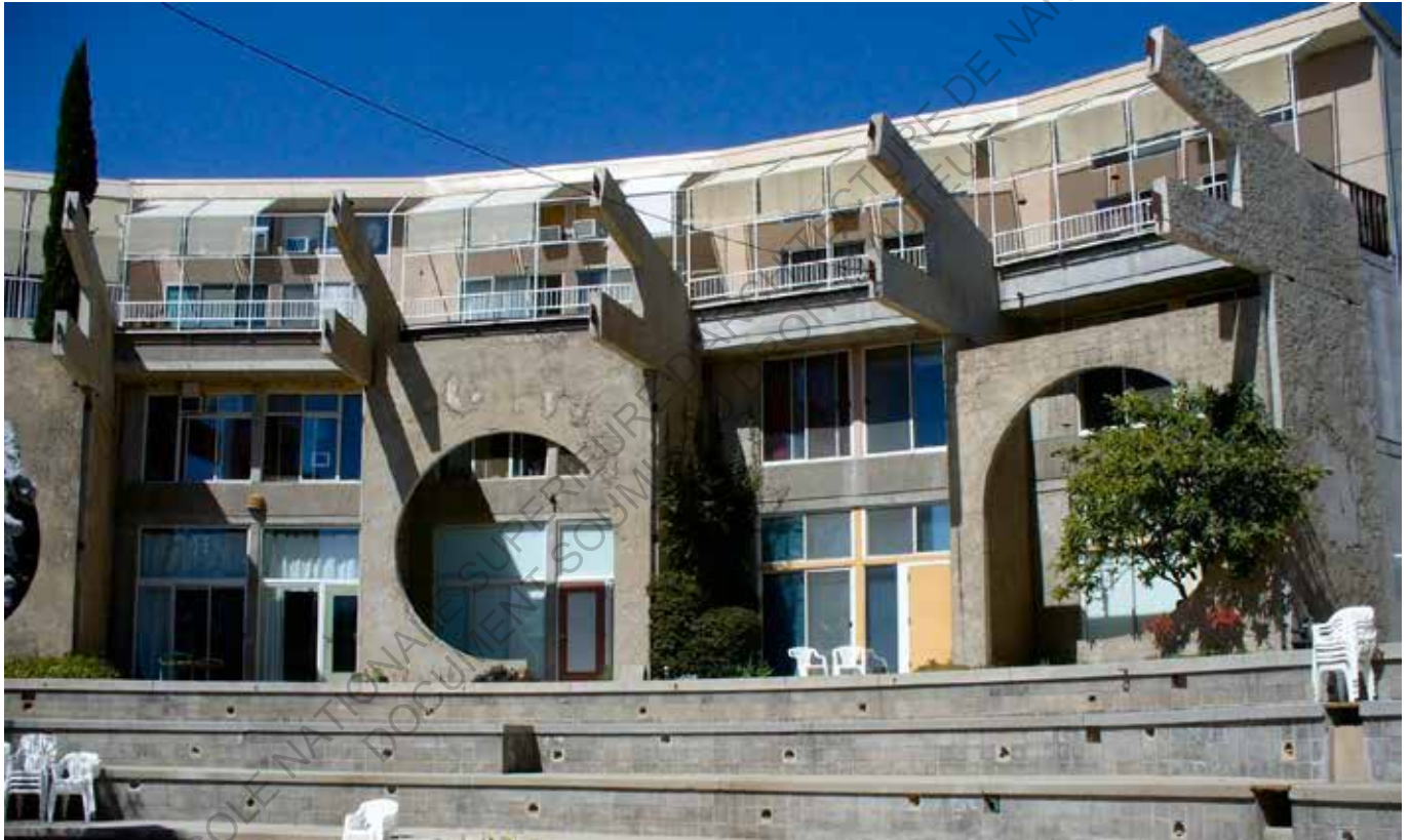
Vue extérieure d'une unité d'habitation, orientée au sud et donnant sur l'amphitéâtre [76]
