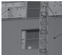
Fig 71 : Phase de chantier de l'opération de Malakoff
