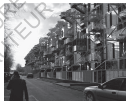
Fig 12 : Barre Euclide à Tourcoing, Atelier Gens Nouveles architectes
