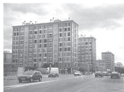
Fig 36 : quartier de l'église à Pantin, Seine-Saint-Denis
