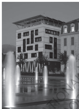
Fig 8 : Immeuble de bureaux, «la bonne énergie» à Grenoble.
