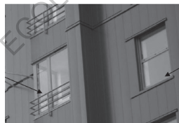
Fig 84 : Bardage métallique en façade et loggias fermées
