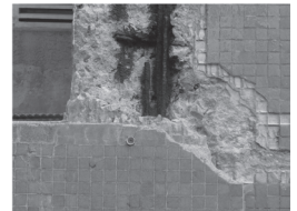
Fig 63 : éclats repérés sur les panneaux préfabriqués
