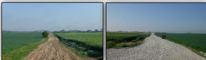
Figures 13 - Chemin d'accès avant et après renforcement
