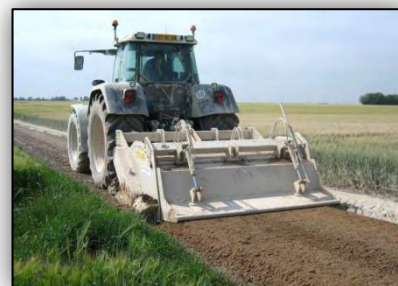
Figure 14 - Création d'un chemin d'accès
