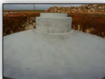
Figure 15 - Fondation avant (ferrailage) et après coulage béton
