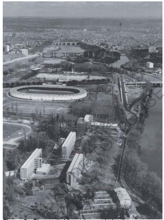
Figure 5. Photographie aérienne de la cité en construction // ©Jean Dieuzaide - 1959
