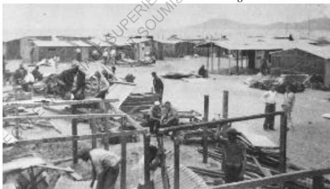
Photo Enrique Tapia, construction des baraques d'Argelès, 15 août 1940
