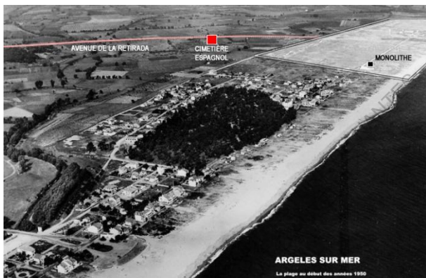
Vue aérienne transmise par Pierre Fuentes, Mairie d'Argelès
