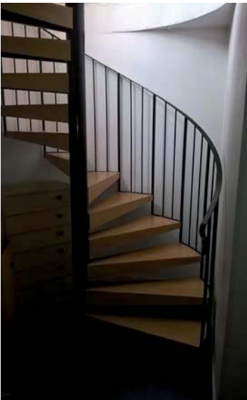
L'escalier était à l'origine entièrement en métal. Des marches en bois ont été ajoutées pour des raisons de confort sonores dans l'appartement
