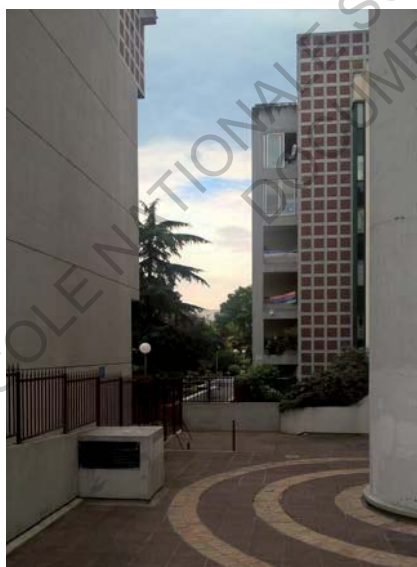
Illustration. 32 Vue depuis la promenade Michel Simon sur les circulations de l'immeuble Nord.
