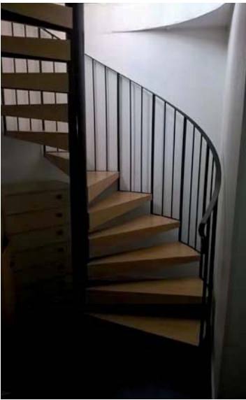
L'escalier était à l'origine entièrement en métal. Des marches en bois ont été ajoutées pour des raisons de confort sonores dans l'appartement
