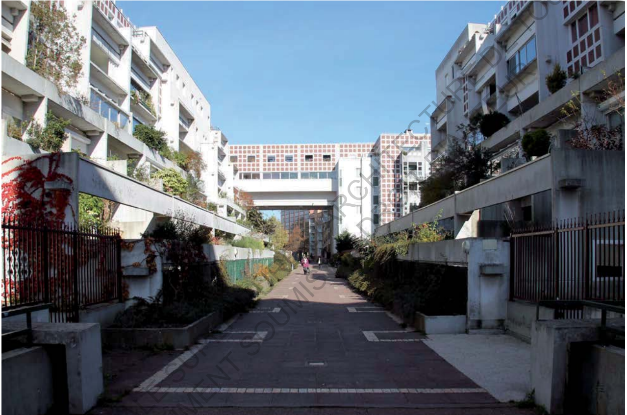
Illustration 1. Vue de depuis la voie piétonne, axe central de Noisy II
