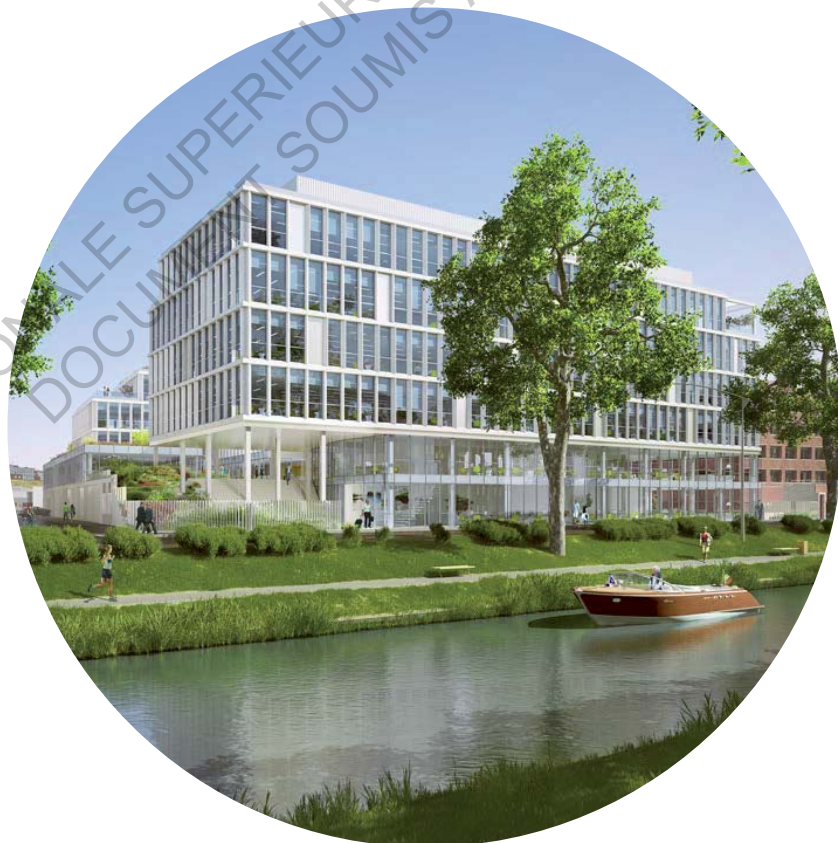
Figure n°32, Vue extérieure de l'immeuble de bureaux Riverside, PPA
