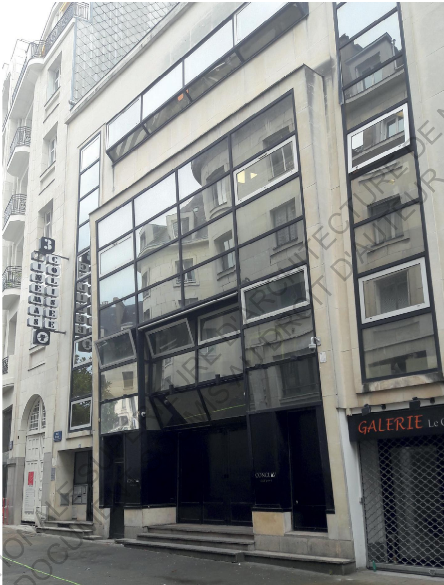
FIGURE 3.Q — L'ancien Colisée, 32 rue Scribe Si le bâtiment est occupé aujourd'hui par une boîte de nuit, l'enseigne témoigne encore de son histoire.
