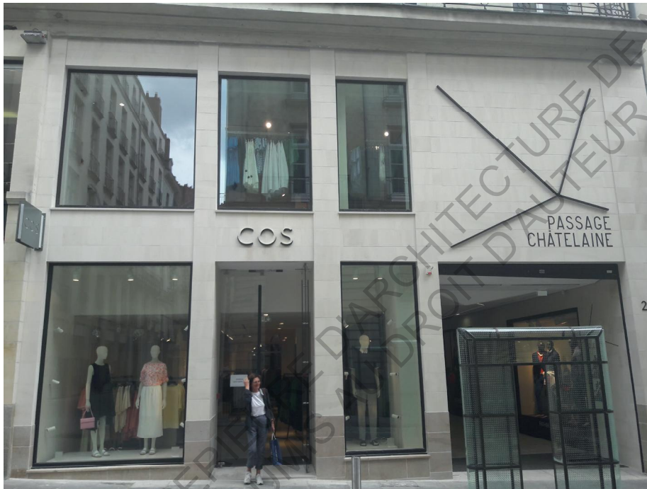
Nouvelle façade rue Crébillon du passage de la Châtelaine livré en 2018
