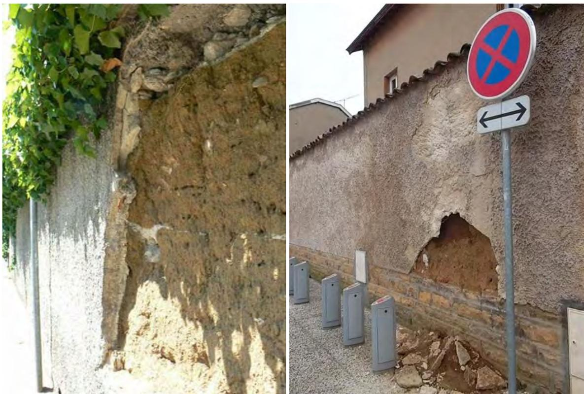
Sinistres sur des murs de clôture, Caluire-et-Cuire, 2015. A gauche (rue de la Gare de Cuire), l'enduit atteint 15 centimètres d'épaisseur. Il a été refait à l'identique au bout de quelques jours. A droite (rue Baudran), l'enduit a été refait à l'identique au bout de quelques semaines. Photo : E. Mille
