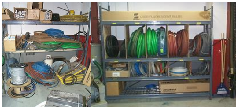
Figure 15 : Application de l'outil 5S en zone de maintenance (19)
