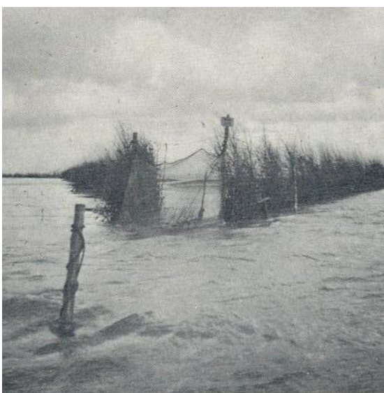
Abb. 5: Arge (Fischfangzaun) vor Norddeich
