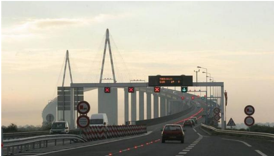
FIGURE 1.9 – Photographie du pont de Saint Nazaire - Source : Ouest France
