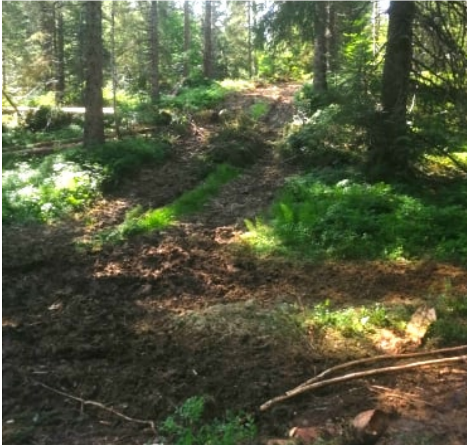
Figure 14 : route endommagée par un tracteur forestier, avant remise en état, à La Féclaz (photo prise sur le terrain en juillet 2019)
