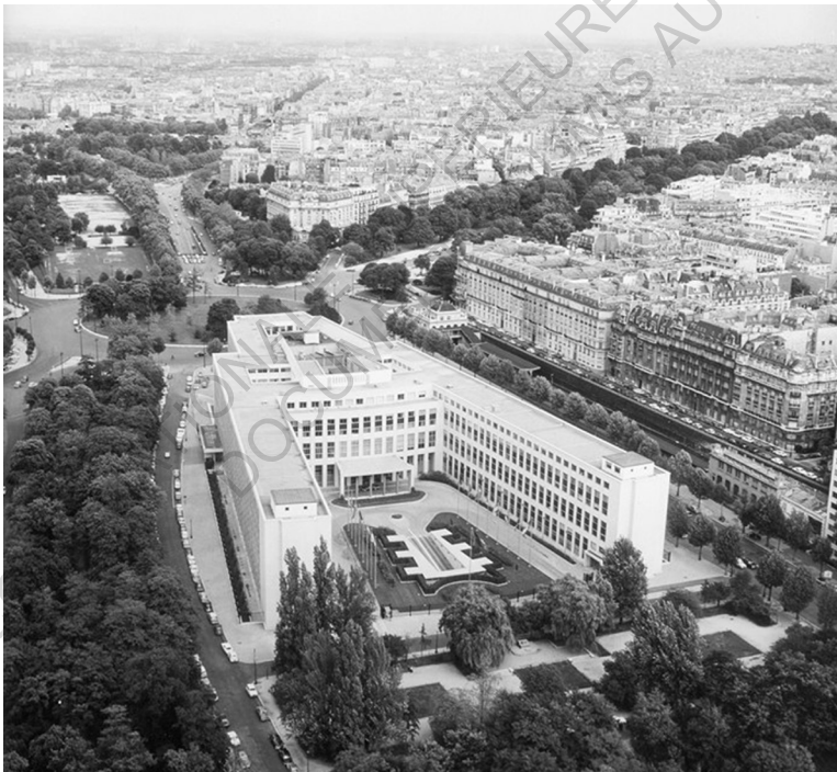
◀ Photographie du bâtiment de l'université Paris Dauphine Source : Site internet de GPAA
