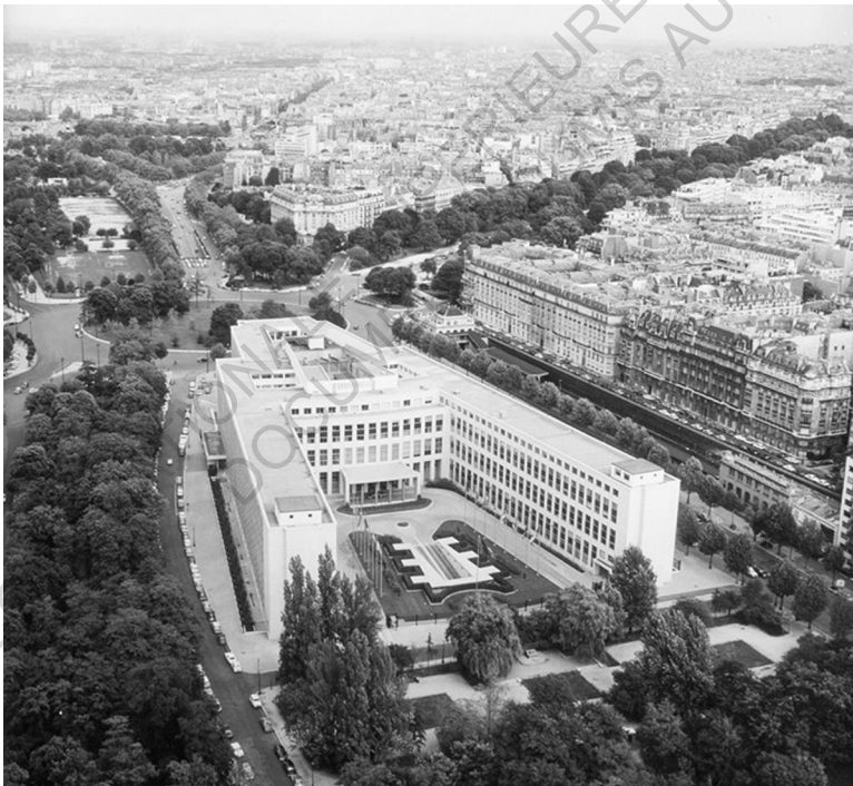
◀ Photographie du bâtiment de l'université Paris Dauphine Source : Site internet de GPAA
