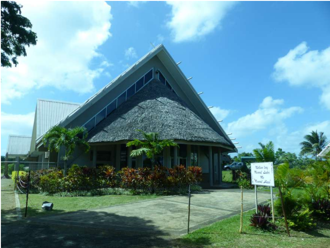
Figure 17 - Bibliothèque municipale, structure anticyclonique (Crédit photo : T.Vauthier, 2018)
