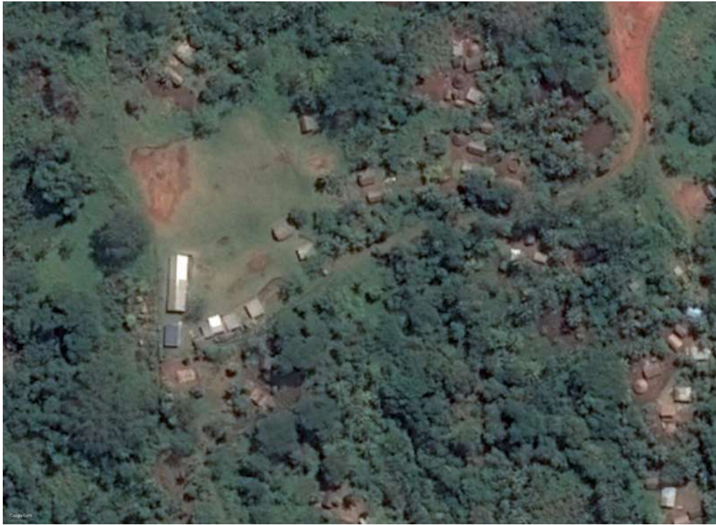
Figure 10 - École primaire d'Enhiu avant le cyclone Pam (Source : Google Earth, 2013)
