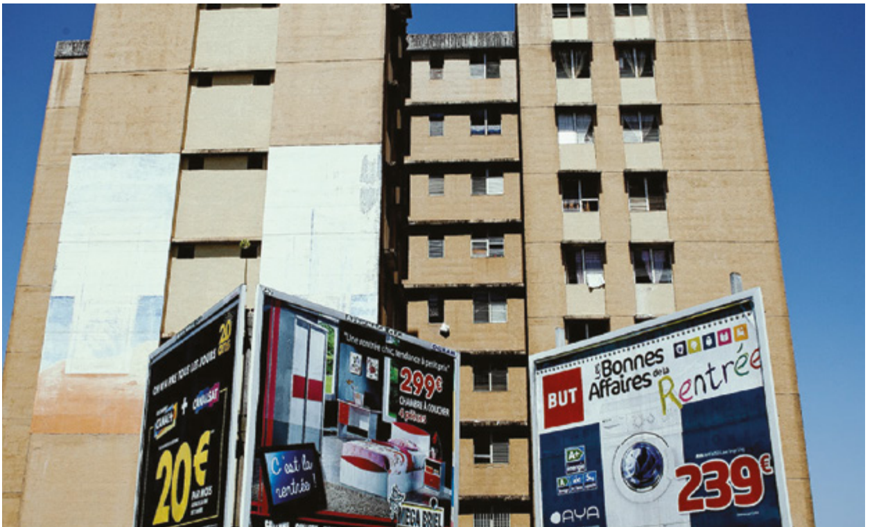
Figure 8. Les tours en 2018 avant leur démolition. Crédits : Mirtho Linguet.
