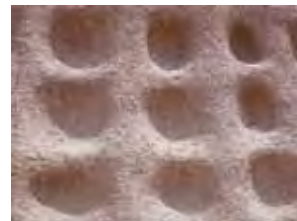
niches dans la façade
