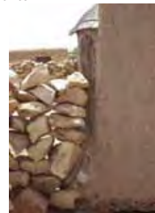
"joints de dilatation" entre clôture et grenier
