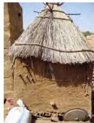
**morceaux de bois encastrés** dans les parois pour créer des **étagères** dans le grenier et suspendre des choses à l'extérieur. Sans doute rôle structurel pour renforcer
