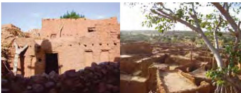
toitures en terrasses jusqu'en bas de la colline
