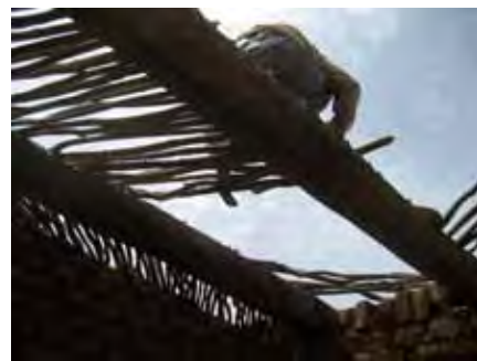
charpente : rôniers et perchettes
