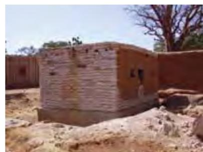
La particularité de ces maisons est d'avoir des murs en pierres sèches taillées à l'Est et au Nord (façades exposées à la pluie), et des murs en briques de banco moulées au Sud et à l'Ouest : une utilisation intelligente et économe des matériaux locaux.
