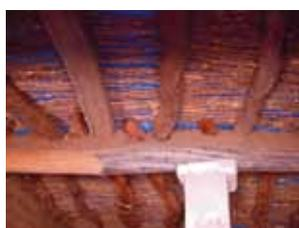
plastique utilisé pour l'étanchéité de la toiture directement sur les perchettes (risque de trous et donc de fuites)
