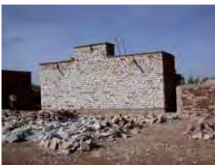
mur en pierres de Ficko achevé
