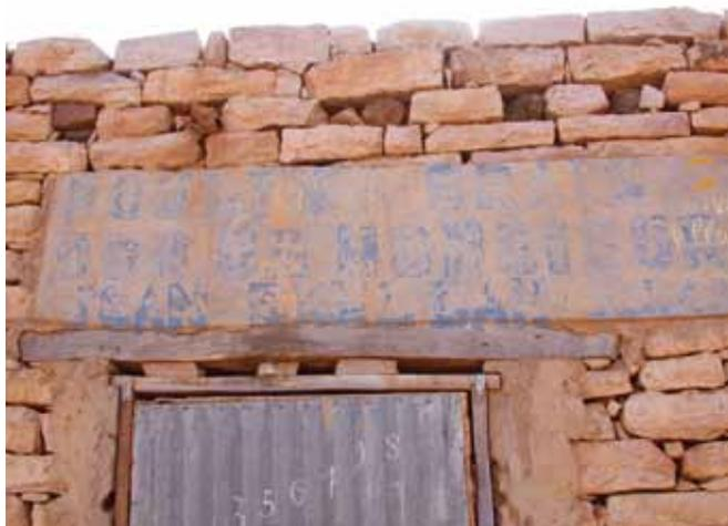
Les soubassements et les murs sont en pierres soigneusement taillées et maçonnées par "une seule main". Un seul maçon a travaillé, ce qui garantit l'unicité de la construction (forme et dimension des blocs, régularité de la maçonnerie)
