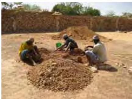
enduit "bandiougou" : gravier latéritique pilé mouillé...
