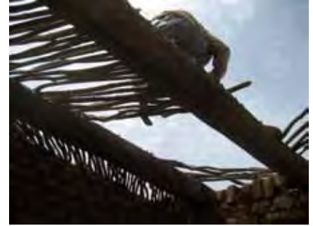
charpente : rôniers et perchettes
