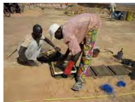
moulage des dalletes en ferro-ciment
