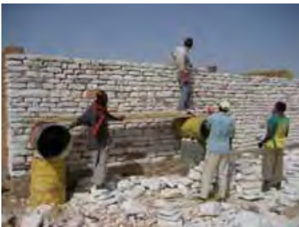
montage du mur en pierre de Ficko
