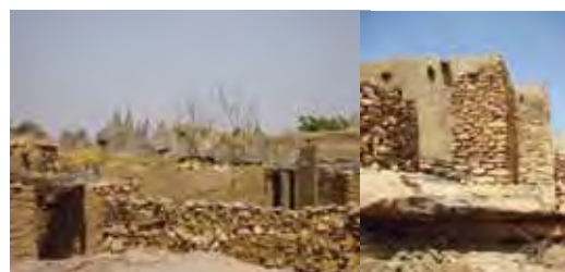
clôture en pierre
