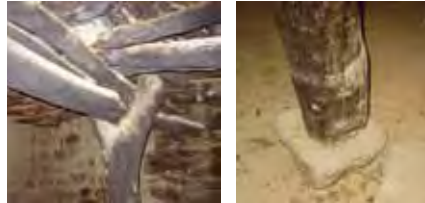
poteaux et poutres : néré et karité, base des poteaux en pierres
