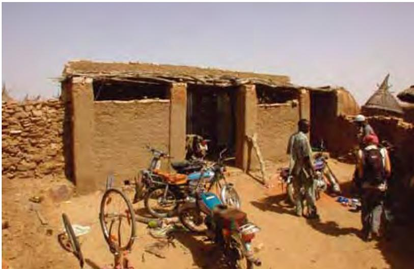
protection du sommet des piliers et des murs en banco avec des pierres : barrière pour l'eau et les termites
