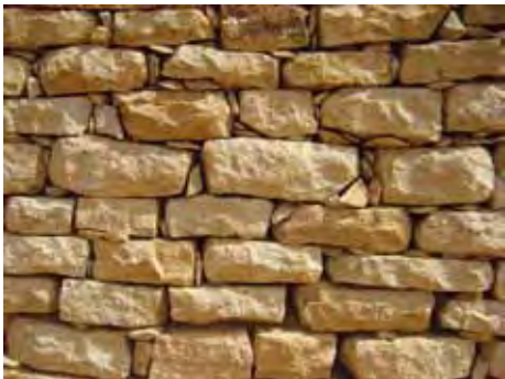
Maçonnerie pierres sèches régulière
