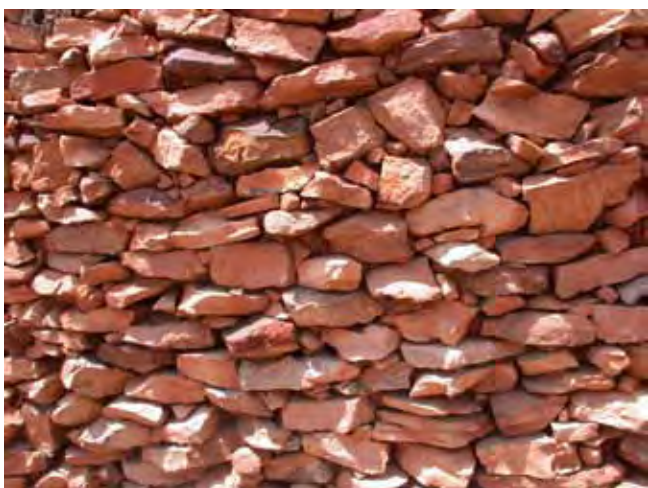
Maçonneries de pierres sèches dans l'ancien et le nouveau village
