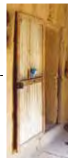
portes : cadre en bois, tôle ondulée
