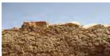
**toiture** : poutres et perchettes en bois, couverture en banco. Au-dessus des murs en banco, il y a des pierres qui protègent le sommet des murs de la pluie
