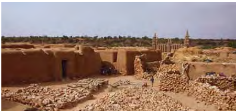
place en bordure d'Orouli Ténéné avec des bancs aménagés
