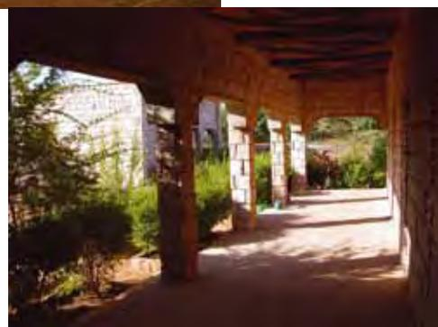
la maçonnerie de pierre s'effectue rapidement grâce à la pose de pierres de part et d'autre du mur et le remplissage du creux central par des chutes et du mortier de ciment.
