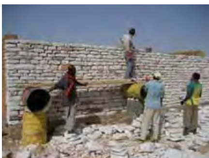
montage du mur en pierre de Ficko
