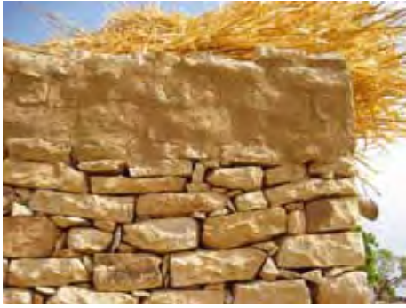
Enduit terre de bas-fond en haut des murs
