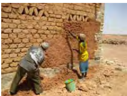
enduit en latérite pilée par des maçons de Bandiougou
