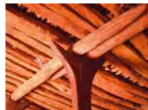
charpente : perches rapprochées (30 cm)
