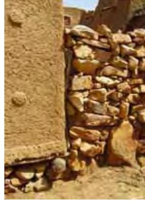
clôture en pierres sèches avec de grosses pierres en bas, puis de plus en plus petites. Joint de "dilatation" entre le grenier et la clôture avec un morceau de bois.
