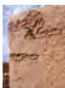
murs : briques « tiembé » fabriquées avec du banco "de rivière" trempé 24 h
