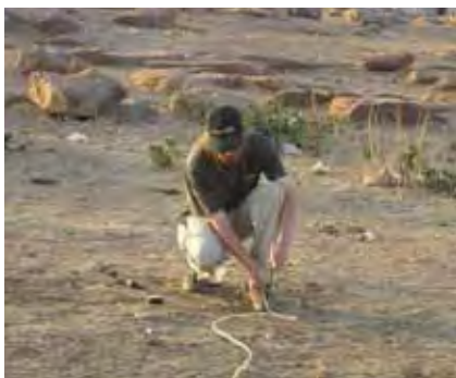
mesure des différences de niveau sur le terrain
