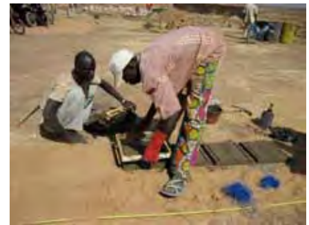
moulage des dalletes en ferro-ciment
