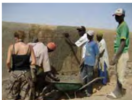
... appliqué en deux couches : la première sans ajouts, la seconde avec différentes recettes
