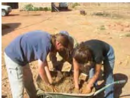
enduit banco jaune stabilisé à 4% de ciment et 1/3 (vol.) de fonio
