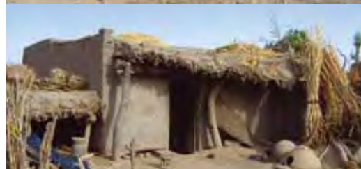
habitations avec des murs en briques de banco non-porteurs
