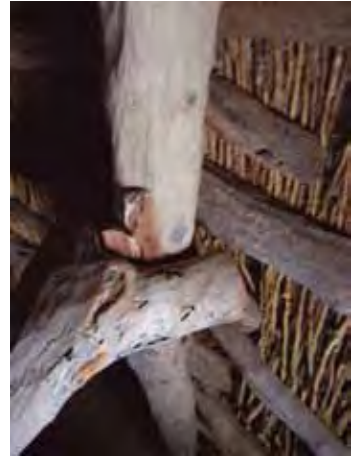
Charpente traditionnelle en gondio
