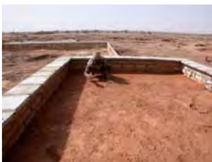
toiture en latérite damée par des maçons de Bandiougou
