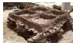
**sol** : plancher en bois composé de **poutres** en bois posées sur les pilotis, de **perchettes** et d'une **couche de banco**
