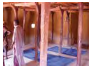
intérieur : enduit jaune et poteaux
