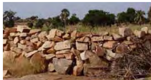
clôture utilisant grosses et petites pierres
