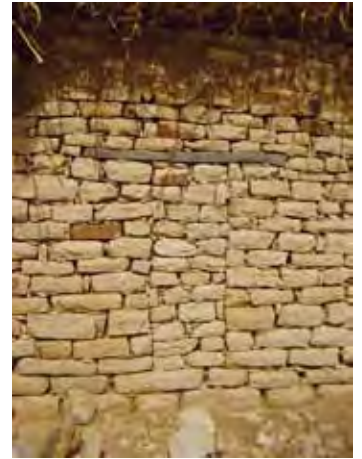
Pré-linteaux en prévision d'une extension
