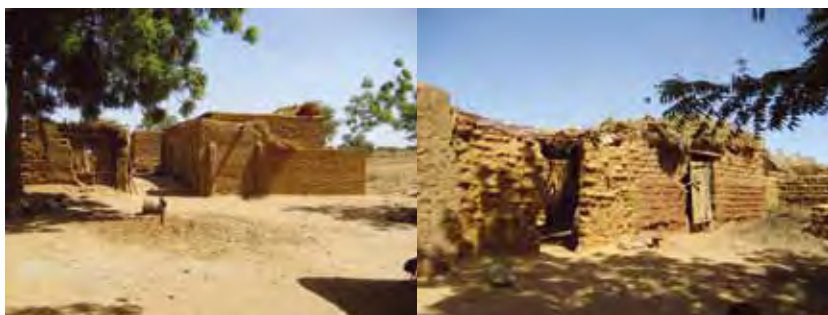
concessions entièrement en briques de banco de terres et d'époques différentes
