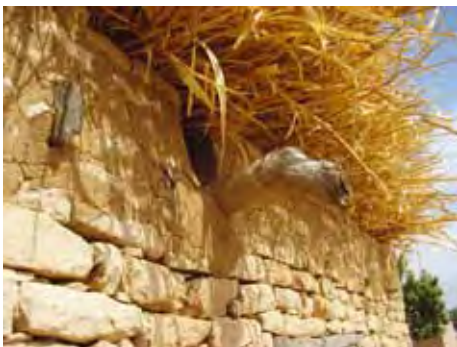
Gouttière en bois
