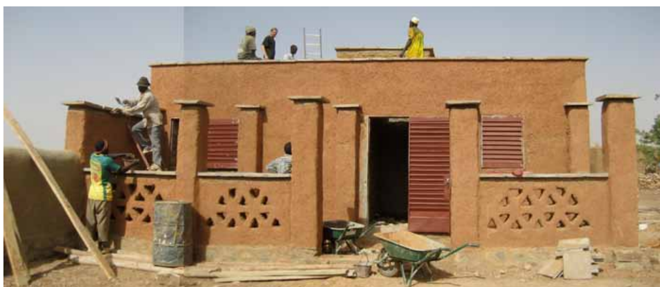
maison du gardien de la mission culturelle de Bandiagara en chantier
