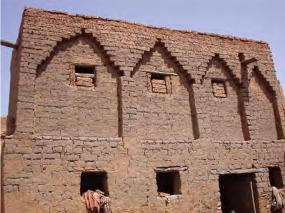
Dans l'extension du village au Sud, plusieurs constructions récentes en briques de banco sont décorées avec des arcs en encorbellement. Ces maisons restent assez complexes, à deux étages avec un escaliers "moderne" à l'intérieur.
