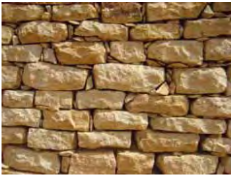
Maçonnerie pierres sèches régulière
