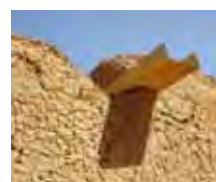
gouttières : en tôle pliée
