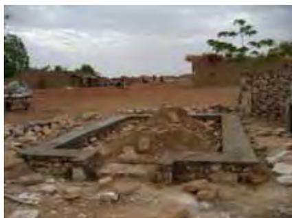
fondations en pierres et soubassement en pierres maçonnées à la terre stabilisée, barrière capillaire ciment
