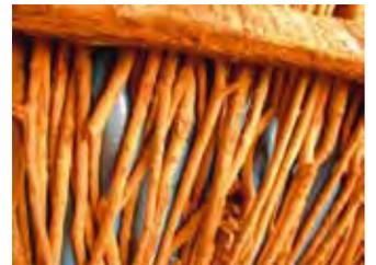
utilisation de plastique pour l'étanchéité au-dessus des perchettes
