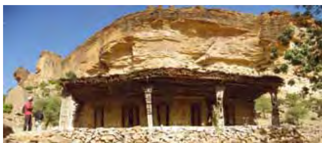
véranda au Sud qui fait de l'ombre sur la façade
