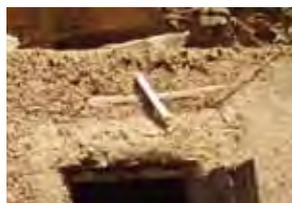
**planche de répartition** : en bois sous la poutre principale, elle permet de répartir le poids de la poutre sur une plus grande portion de mur afin d'**éviter les fissures**
