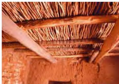
La toiture reprend la toiture traditionnelle avec une charpente plus régulière (roniers), moins de bois, et une couche de plastique.
