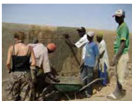
... appliqué en deux couches : la première sans ajouts, la seconde avec différentes recettes
