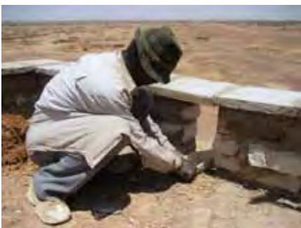
mise en place de la gouttière en bois
