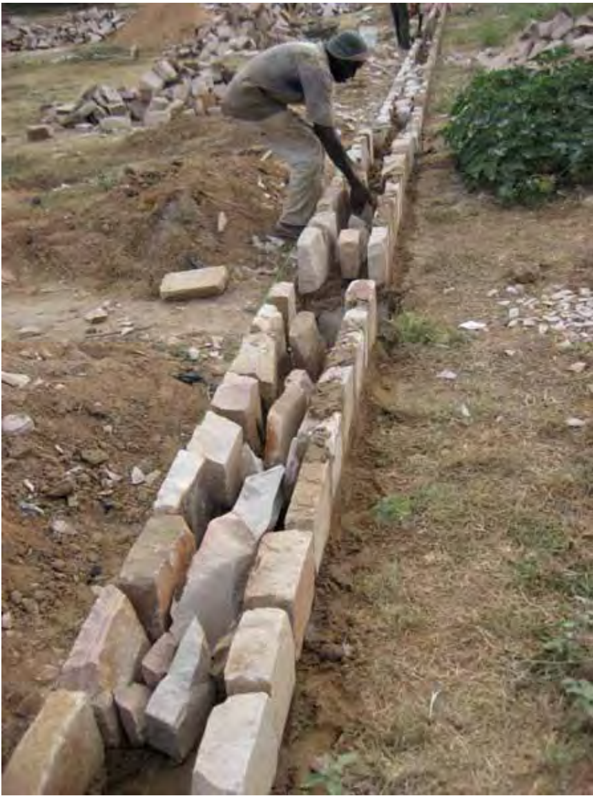
soubassement-fondation sur un chantier à Bandiagara
