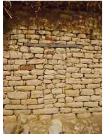
Pré-linteaux en prévision d'une extension
