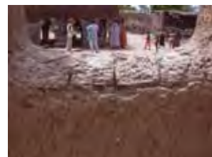
briques très fibrées en haut des murs
