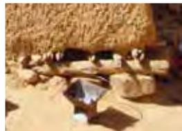
**sol** : Plancher en bois composé de poutres en bois posées sur les pierres, de perchettes et d'une couche de banco
