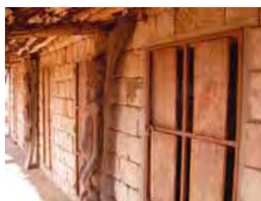
poteaux sculptés et portes permettant la ventilation image : Wolfgang Lauber
