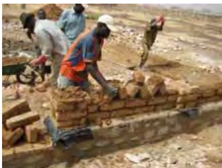
maçonnerie briques de banco
