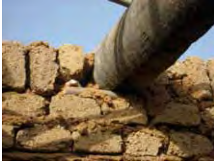
perchettes pour répartir les charges sous la poutre
