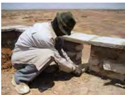
mise en place de la gouttière en bois
