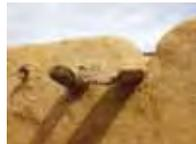
**soubassement :** pierres non-taillées **maçonnées au banco** sur **1 m** de hauteur
