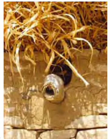
Gouttière en bois
