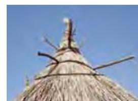
**toiture** : pointue en **paille**, elle recouvre le grenier terminé sphériquement en terre façonnée
