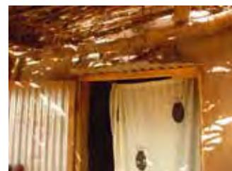
intérieur : dalle béton au sol et enduits en banco soigneusement finis
