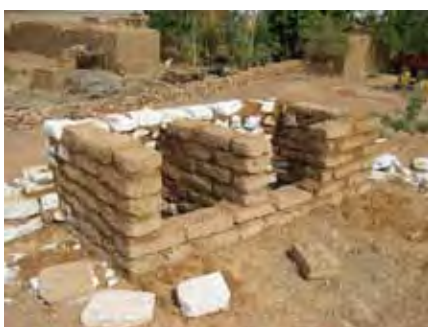
cheminées de ventilation
