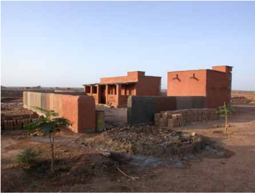
bâtiments et clôture "bogolan" enduits
