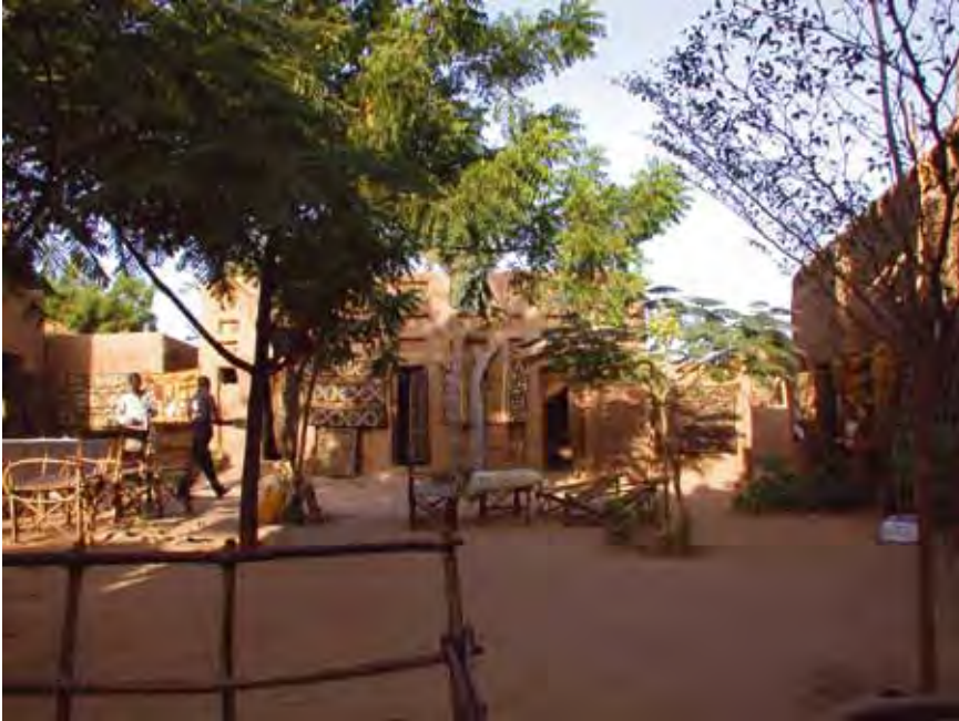
cour délimitée par les bâtiments-chambres
