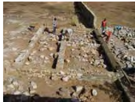
soubassement en pierre maçonnée à la terre stabilisée, barrière capillaire ciment
