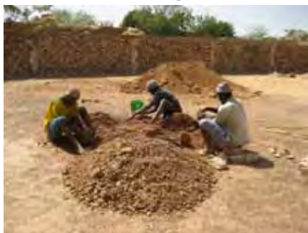
enduit "bandiougou" : gravier latéritique pilé mouillé...
