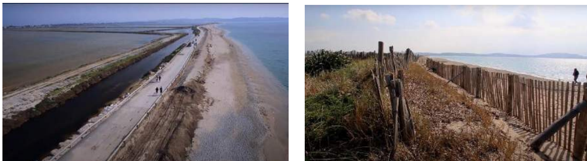
Fig 53 La protection du tombolo ouest pour lutter contre l'érosion et la submersion
