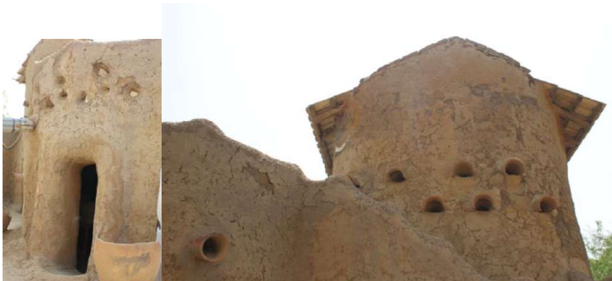
Figure 25 : photographie de la partie centrale du palais , photographie personnelle, juin 2019
