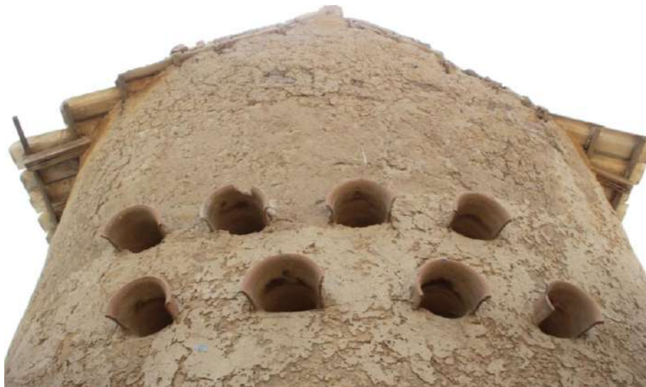
Figure 18 : photographie des oculi en partie haute d'une des tours du palais , photographie personnelle, juin 2019
