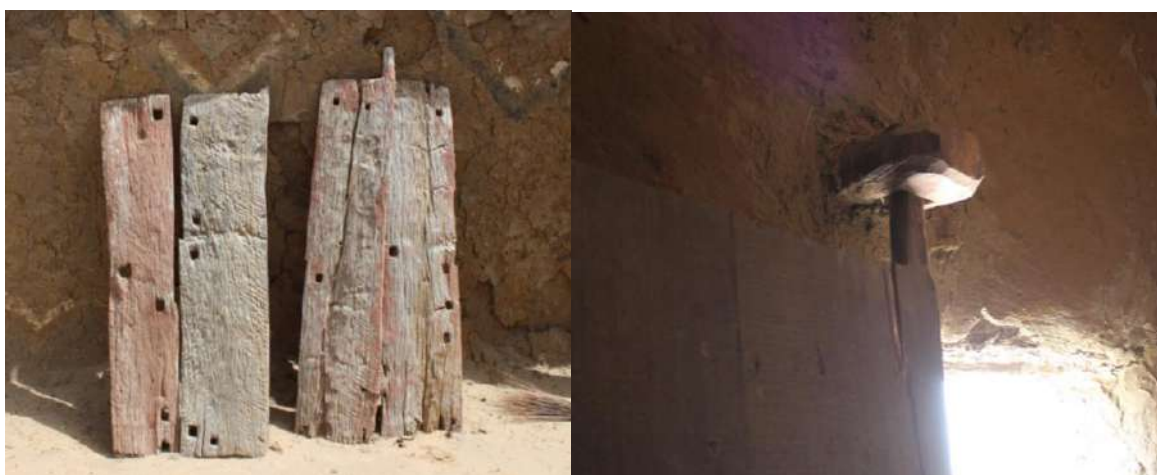
Figure 21 : photographie de battants de porte en bois , photographie personnelle, juin 2019
