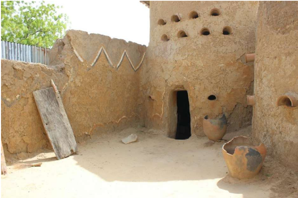
Figure 40 : photographie du palais , photographie personnelle, juin 2019
