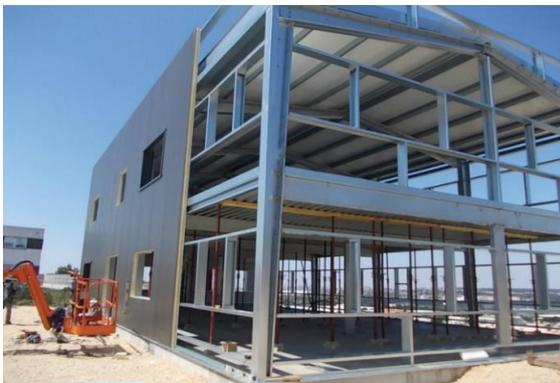
**Figure 4 : Élément 2D métallique pour la construction**
