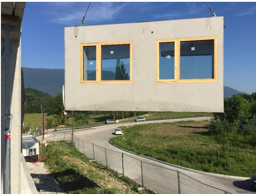
Figure 5 : Panneau de façade préfabriquée de l'industriel Elmere. Source : Centre de documentation du Groupe Pelletier.
