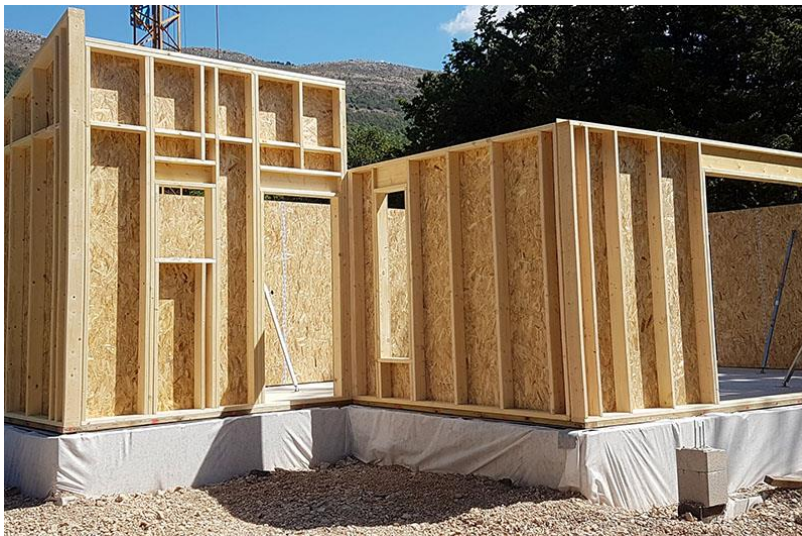
Figure 3 : Photo de panneaux en ossature bois. Source : Lesage Construction Bois, site internet
