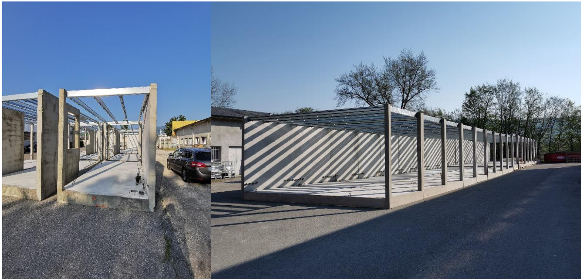
Figure 7 : Modules de construction hors-site de l'entreprise Alpha M. 3D. Source : Photo prise par Theo JEANTILS
