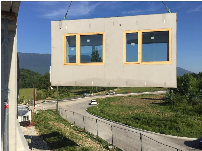
**Figure 5 : Panneau de façade préfabriquée de l'industriel Elmere. Source : Centre de documentation du Groupe Pelletier.**
