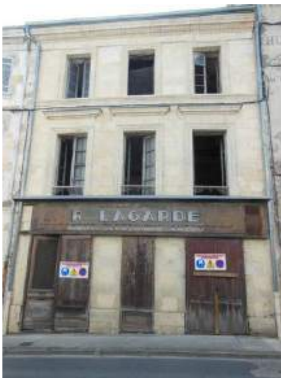
Figure 23: Photographie de l'immeuble Gambetta "G", état existant Dauphins Architecture
