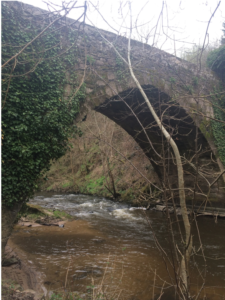
Cliché 5 : Pont médiéval de Boussac, angle Nord-Est, Etienne Ménager, 2017
