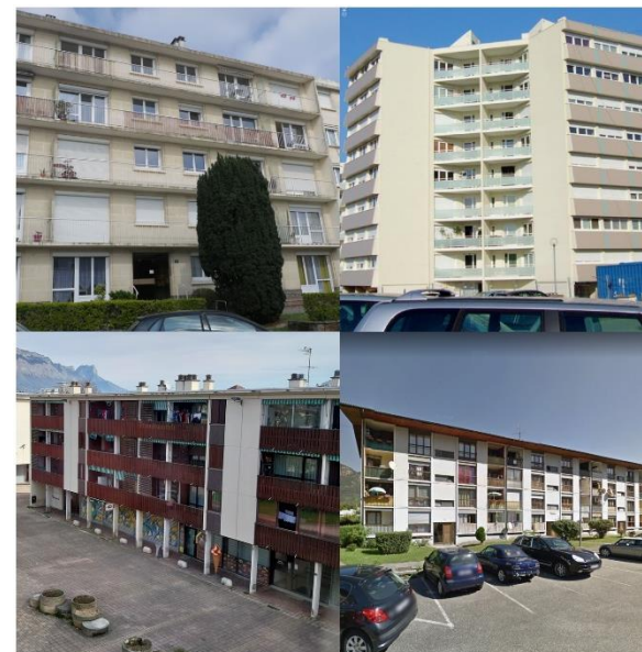
Photo 4 : Copropriétés construites entre 1960 et 1974 - Source : URBANIS ; programmeprofeel.fr ; expertisestructure.com
