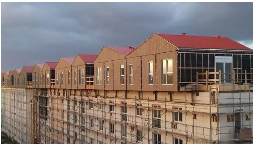
Photo 16 : Surélévation urbaine : Des maisons sur les toits des immeubles à Poissy - Source : news.cision.com
