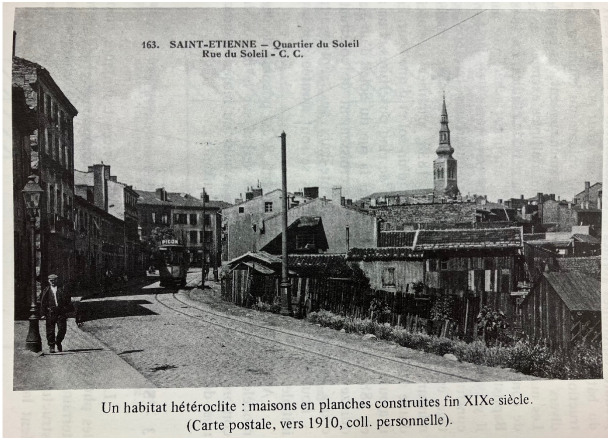
Figure 6 : les baraquements du quartier du Soleil, début du XXe siècle, issu de Burdy, Jean-Paul. Le Soleil noir, un quartier de Saint-Etienne : 1840-1940 , Lyon, Presses universitaires de Lyon, 1989.
