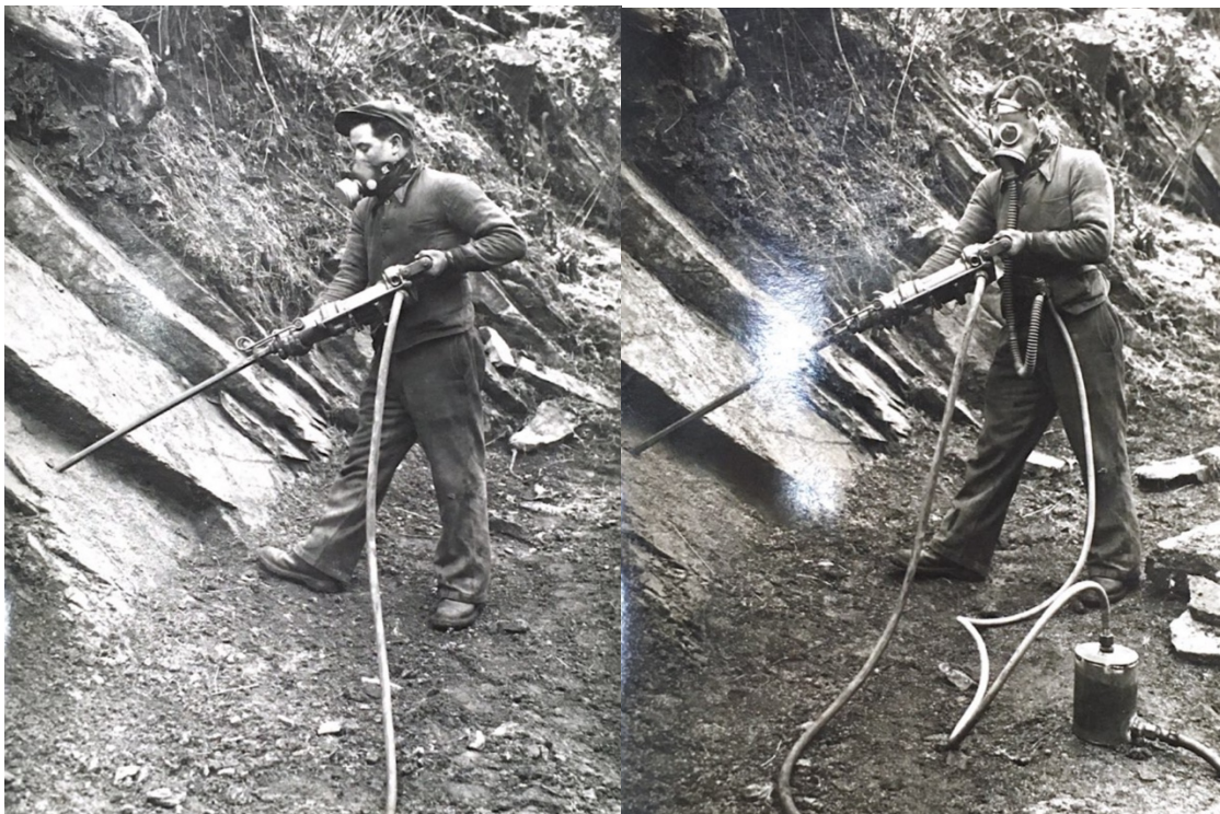
Figure 11 : ADL 1 ETP 2274, photographies de présentation des équipements de sécurité contre la silicose, marteau à injection d'eau et masques, Mines de la Loire, années 1930.
