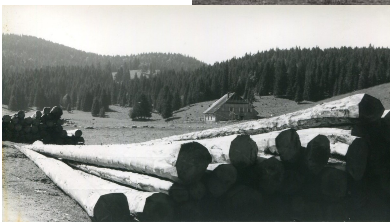
Illustration 21: Bâtie dessous, vue d'un autre angle
